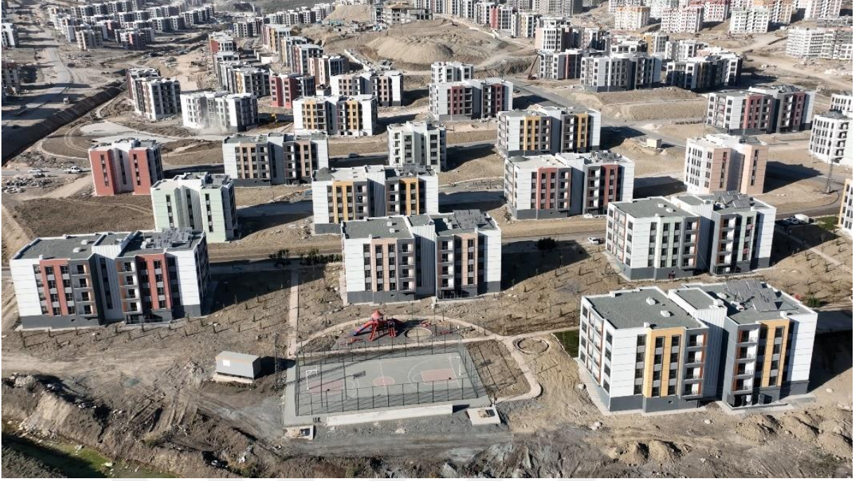
Resim 2.3. 2023 Kahramanmaraş Sonrası Yapılan Hatay Toki Konutları (URL-3)
