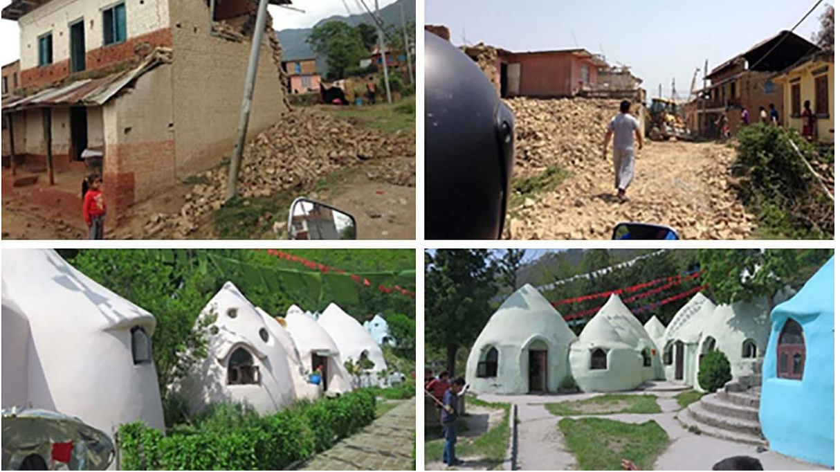
Resim 2.17. Pakistan – 2005 Keşmir Depremi Sonrası inşa edilen konutlar (URL-17)
