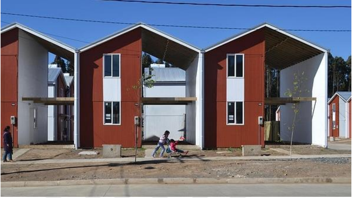
Resim 2.18. Şili – 2010 Depremi Sonrası Konutların Yarı Bitmiş Şekilde İnşa Edilmiş Hali (URL-18)
