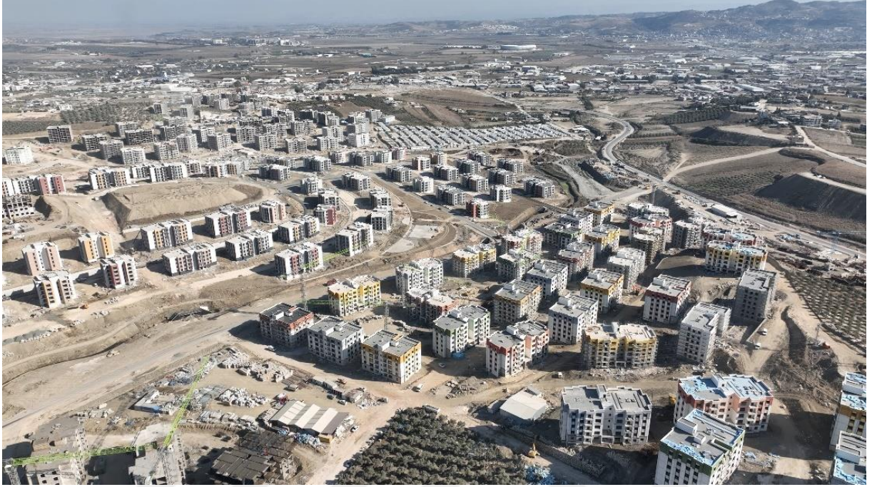
Resim 2.14. Kahramanmaraş depremi sonrası Hatay Dikmece TOKİ konutları (URL-14)
