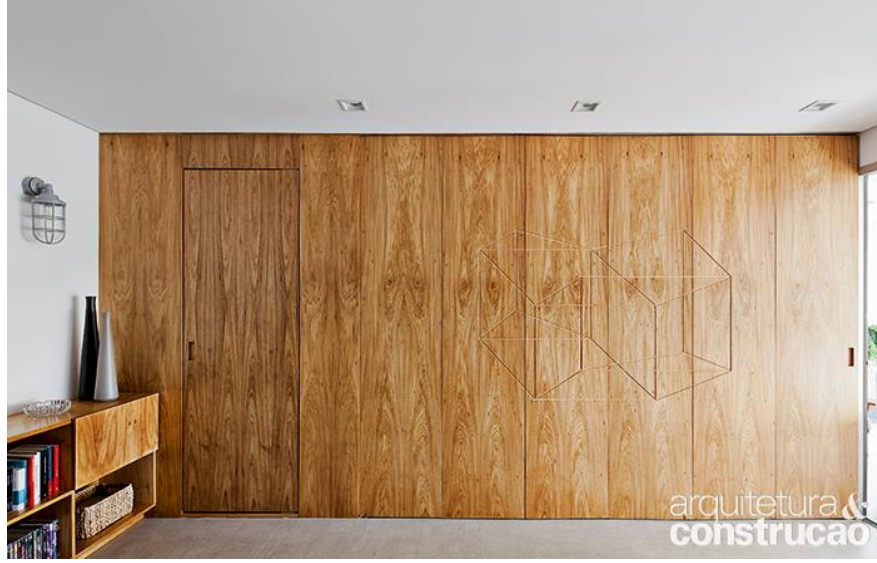
Şekil 33.5 Ahşap esaslı katlanır panel duvar . Elektronik kaynak: https://arquiteturaeconstrucao.abril.com.br/apartamentos/marcenaria-e-a-estrela-do-projeto/amp/
