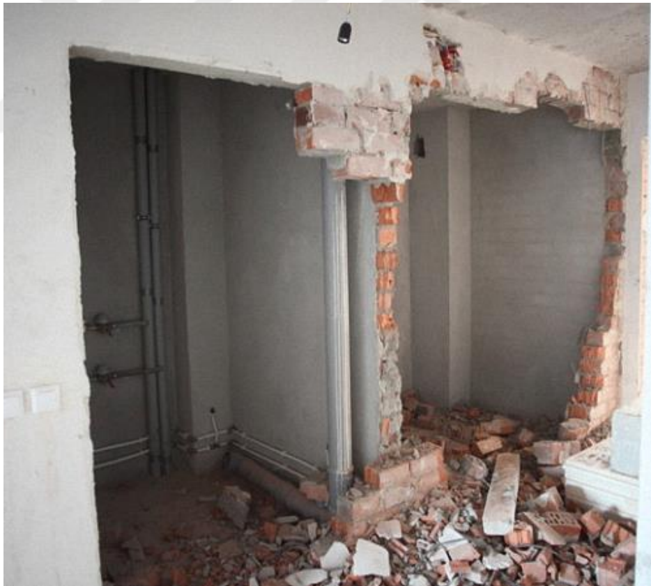
řekil 3.1 Tuėla Duvarın Yıkılmasıyla Yapılan Tadilat. Elektronik kaynak: http://maddyyoung.com/13849
