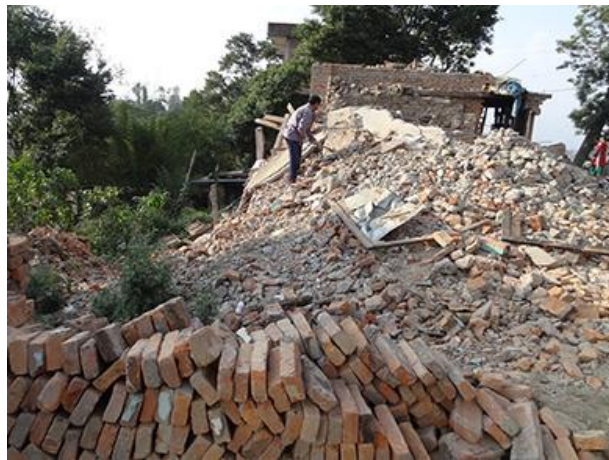
Şekil 1.7 Nepal'de inşa edilecek kalıcı konutlar için yıkıntılardan geri dönüştürülme işlemi. Elektronik kaynak: http://www.shigerubanarchitects.com/works/2015_nepal_earthquake-2/index.html Son erişim: 25.08.2017
