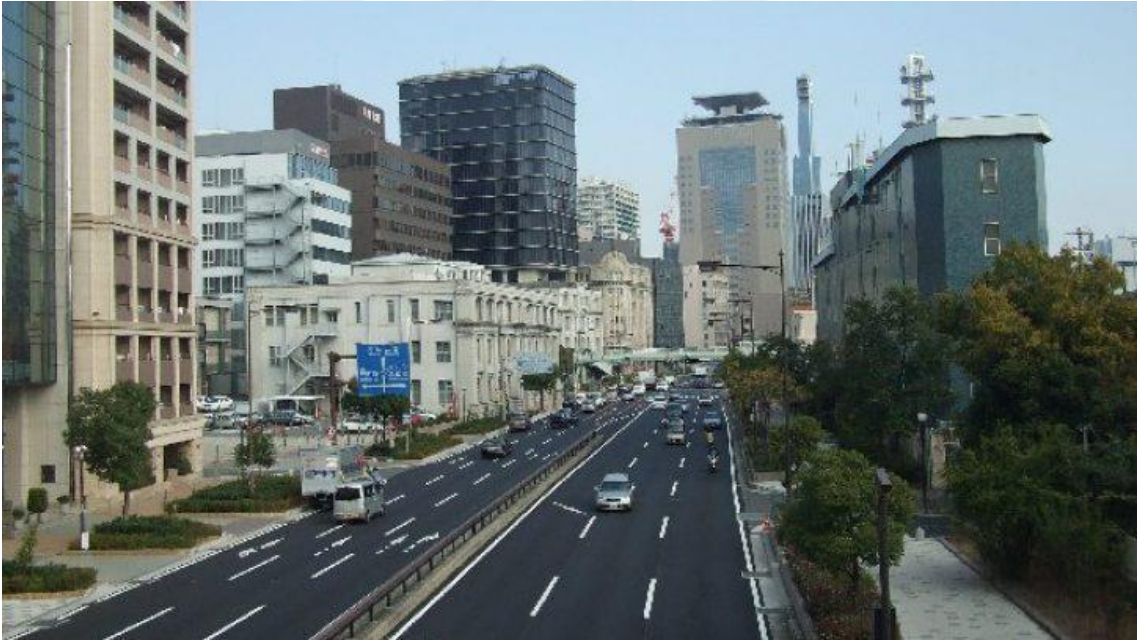
Şekil 2.9 Deprem Sonrası Kobe (Url-8)
