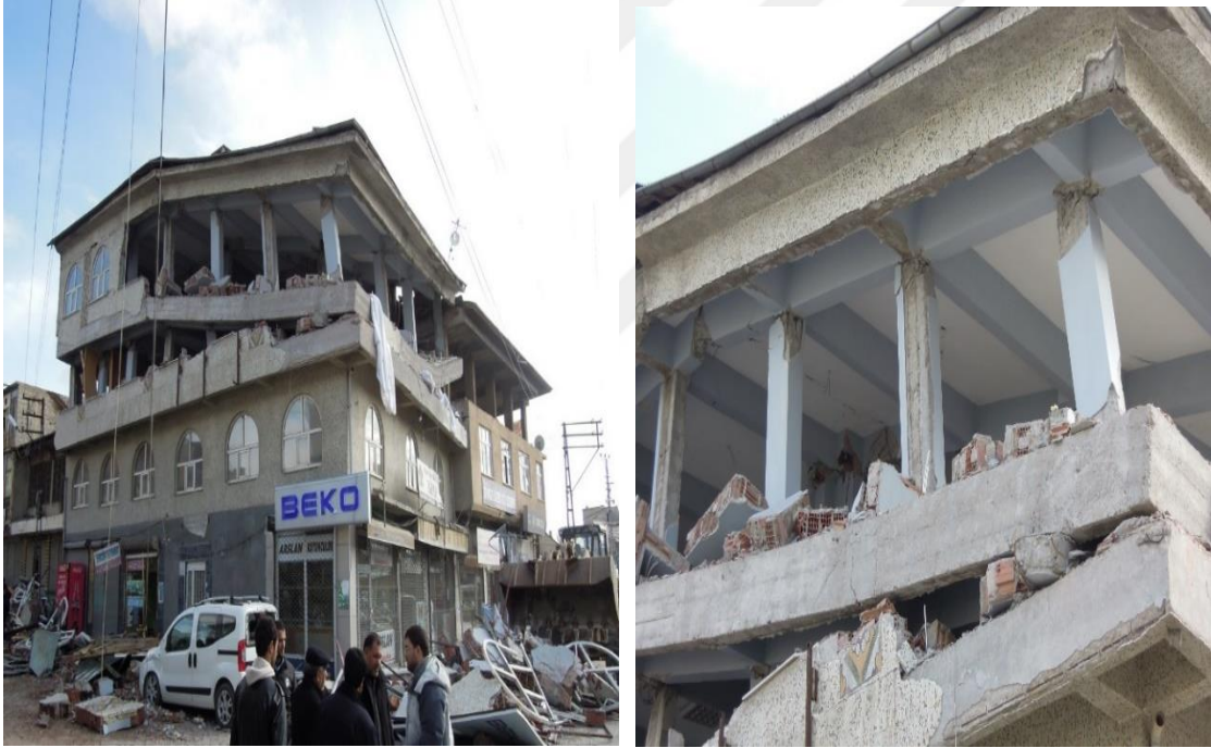
Şekil 3.7. Zayıf kat örneği (sonradan yapılan üst 2 kat) (http-6)
