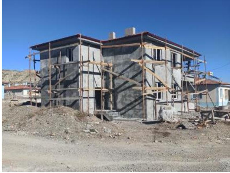
Şekil 4.27. İnşaata devam eden kalıcı afet konutu (Kuz, 2020 arşivi)
