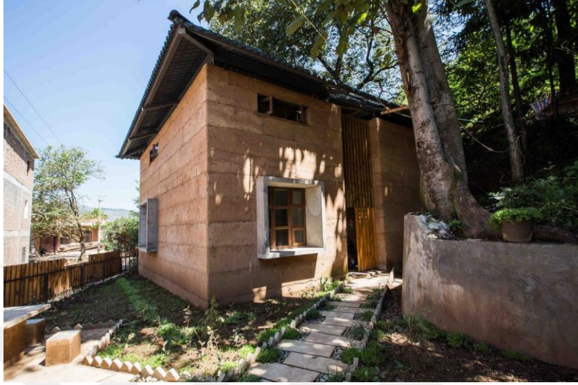
Şekil 3.12. İnşa edilen kalıcı afet konutu (Anonymous, 2017)
