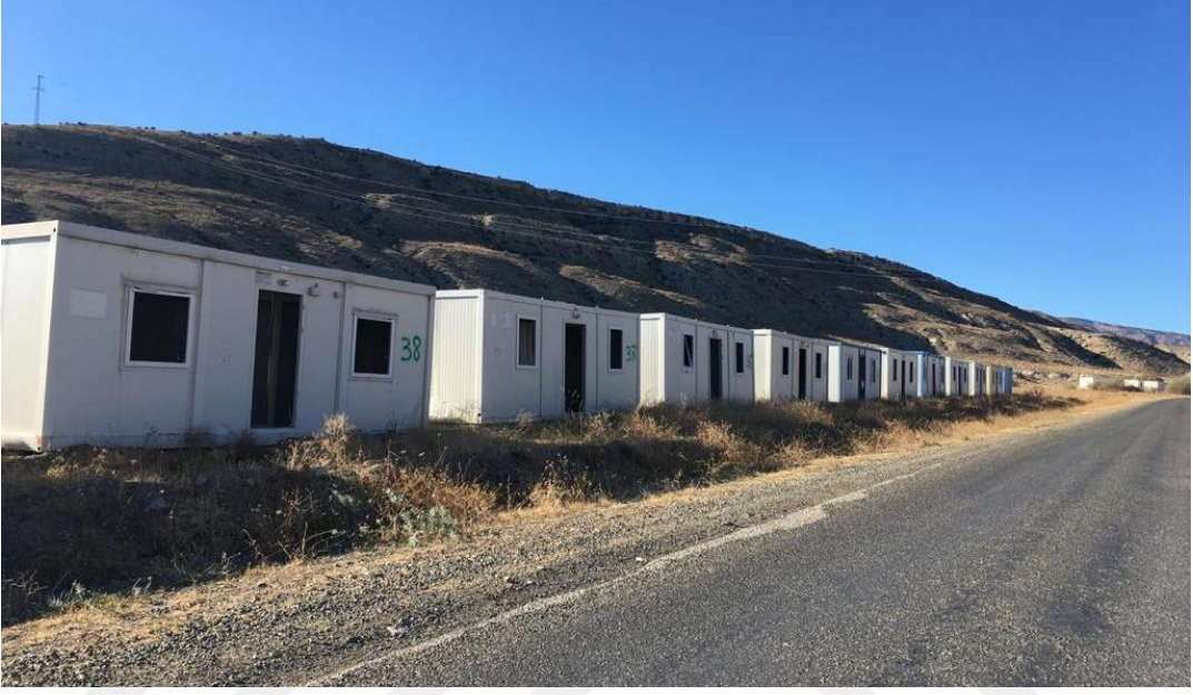
Şekil 4.12. İnandık Köyü sakinleri için yapılmış olan konteyner geçici afet konutları (Kuz, 2020 arşivi)
