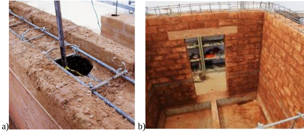
Şekil 3.10. Sismik güçlendirmeli sıkıştırılmış-toprak duvarlı yapım tekniği (Anonymous, 2020)
