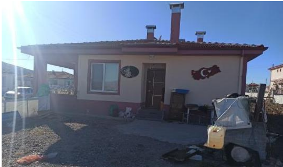
Şekil 4.20. Tek katlı kalıcı afet konutu örneği (Kuz, 2020 arşivi)
