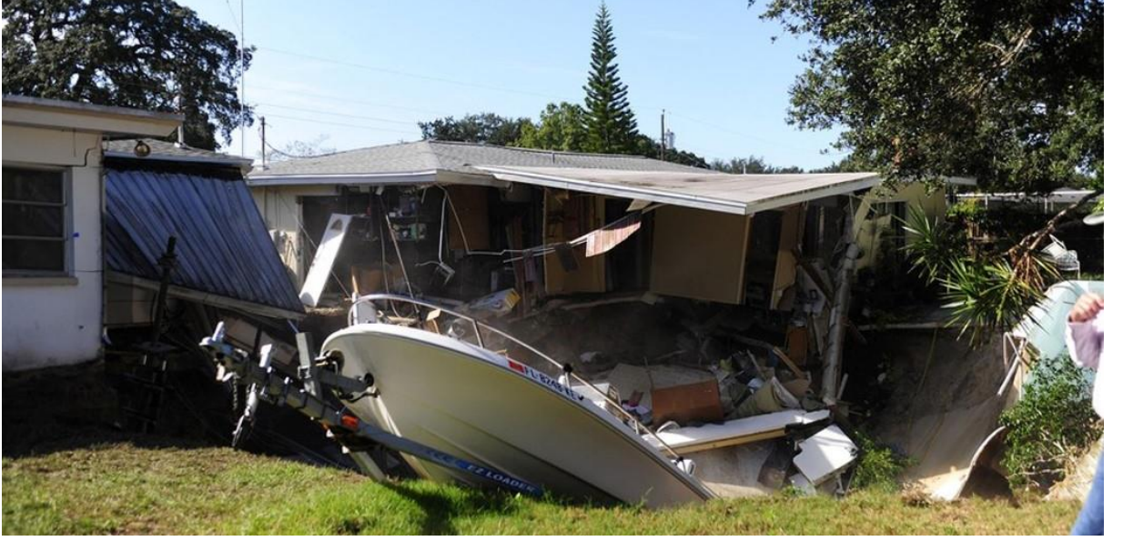
Şekil 2.9. Amerika’da yerleşim yerinde meydana gelmiş obruk örneği (Şahin, 2016).
