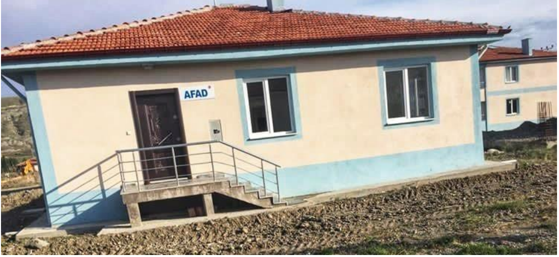
Şekil 4.23. İnandık Köyü kalıcı afet konutu (Kuz, 2020 arşivi)
