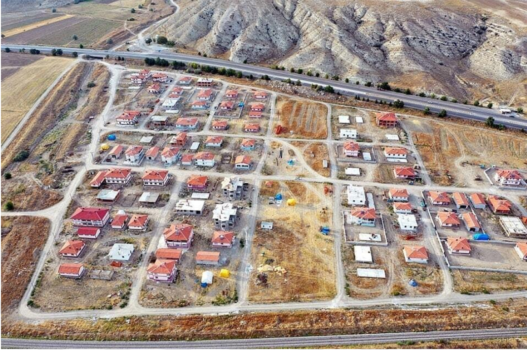
Şekil 4.19. İnandık Köyü kalıcı afet konutları yerleşkesi (İnandık Köyü, 2020 arşivi)
