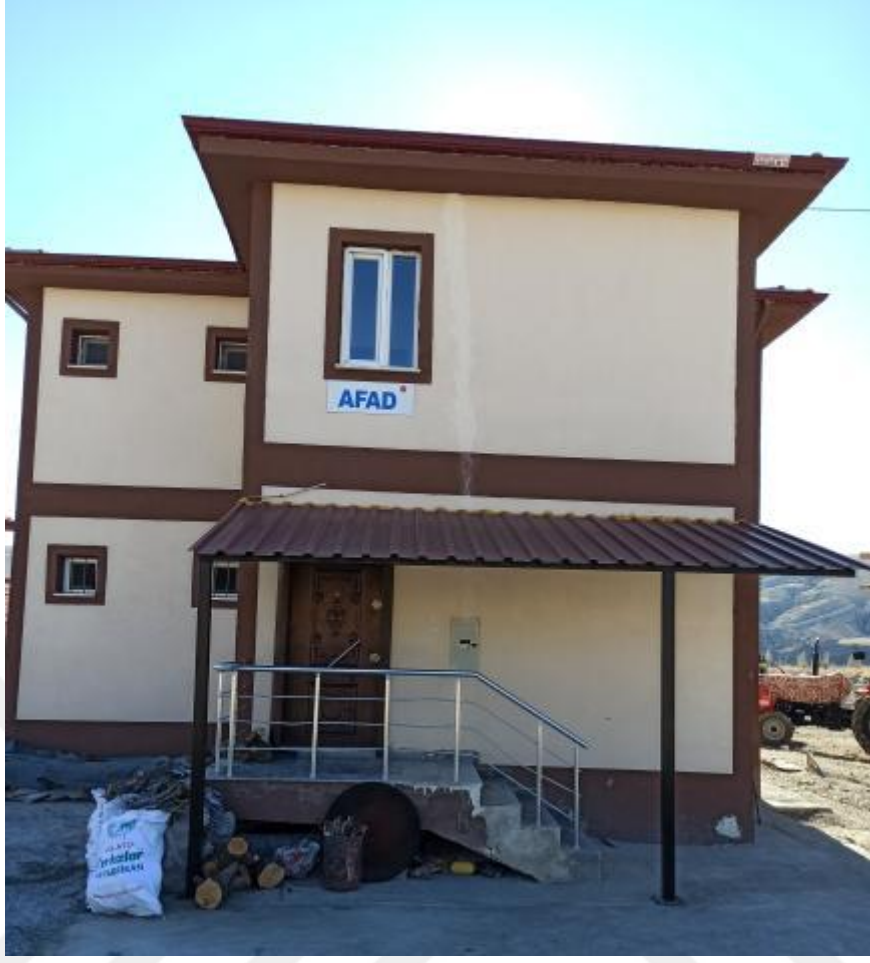
Şekil 4.22. İnandık Köyü kalıcı afet konutu (Kuz, 2020 arşivi)
