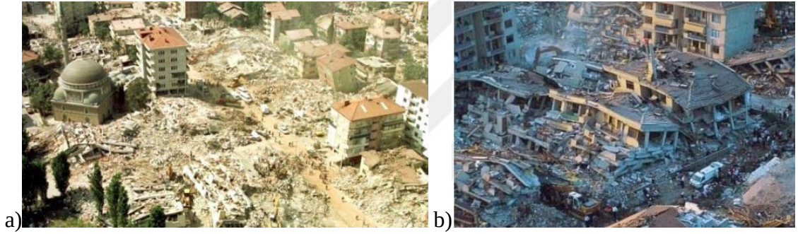
Şekil 2.1. Gölçük Depremi sonucu oluşan yıkım (Dayanır, 2019)
