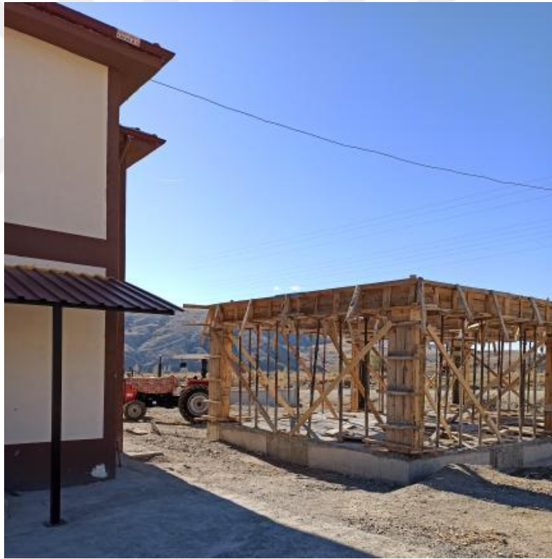
Şekil 4.28. İnandık Köyü kalıcı afet konutu ve inşaata devam eden ahır projesi (Kuz, 2020 arşivi)
