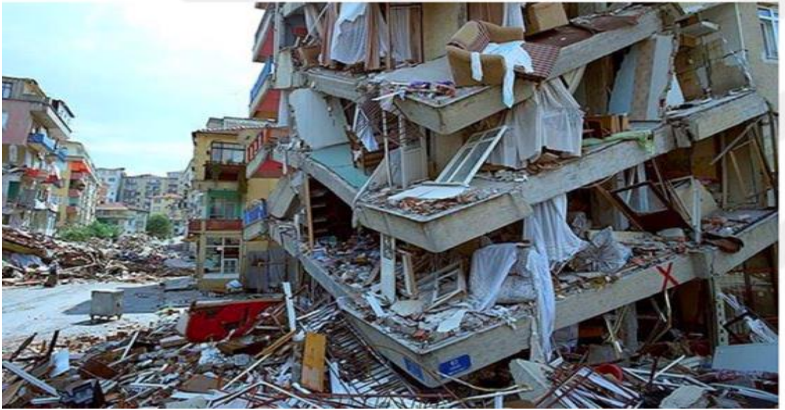
Şekil 30. 1999 Kocaeli Depremi'nde planda çıkıntılar bulunan bir binada meydana gelen deprem hasarı (Döndüren ve Nakipoğlu, 2016).
