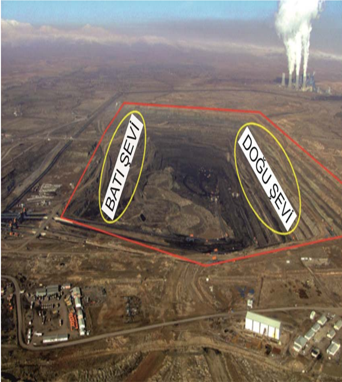
Şekil 5.5 : Batı ve doğu şevlerinin heyelandan önce güneyden görünümü.
