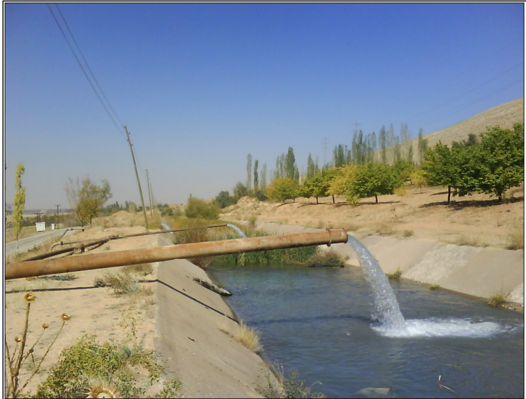
Şekil 4.4. İşletme drenaj kanalı (AEL İşletmesi KD şev üstü Kışlaköy köyü civarı)
