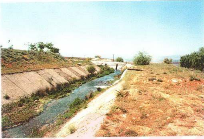
Şekil 4.48. AEL-TKİ İşletmesinde Deşarj Suları ve Atık Suların Boşaltıldığı Kızıldağ Eteklerindeki Drenaj Kanalı
