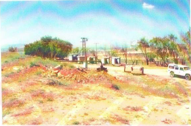
Şekil 4.47. Maden Alanında Biriken Yeraltı ve Yüzey Sularının Deşarjını Sağlayan Pompa İstasyonu
