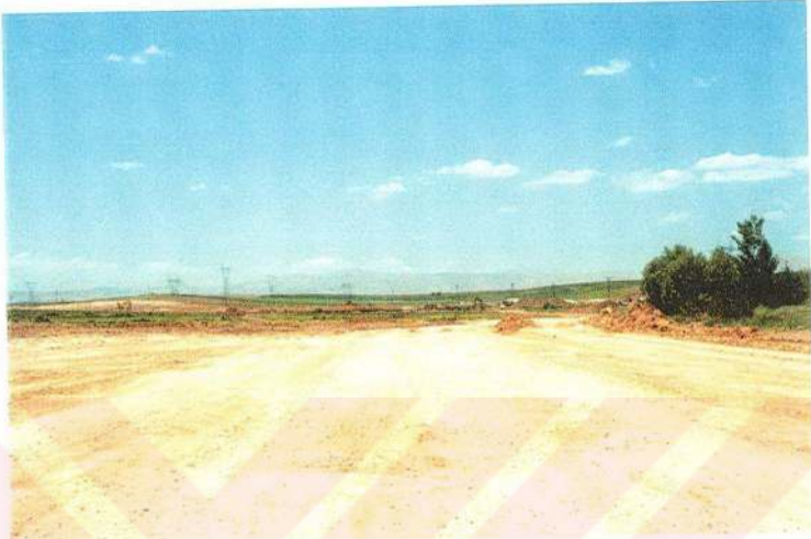
Şekil 4.10. AEL Çöllolar (B) Bölümü İnşaat Alanı
