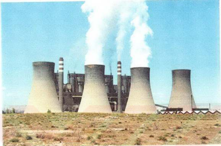
Şekil 4.9. Afşin-Elbistan Termik Elektrik Santrali'nden Bir Görünüm
