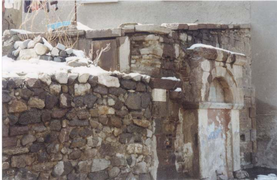
Resim No: 51 Hacı Nasuh Çeşmesi Yan Görünüş
