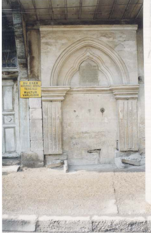
Resim No: 57 Sülüm 1 Çeşmesi Ön Görünüş
