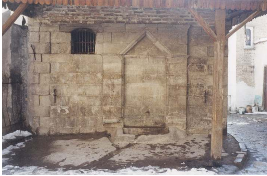
Resim No: 79 Hacı Aftal Çeşmesi Ön Görünüş
