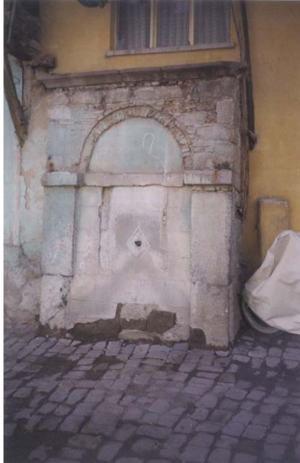
Resim No: 33 Bel Mescid Çeşmesi Ön Görünüş
