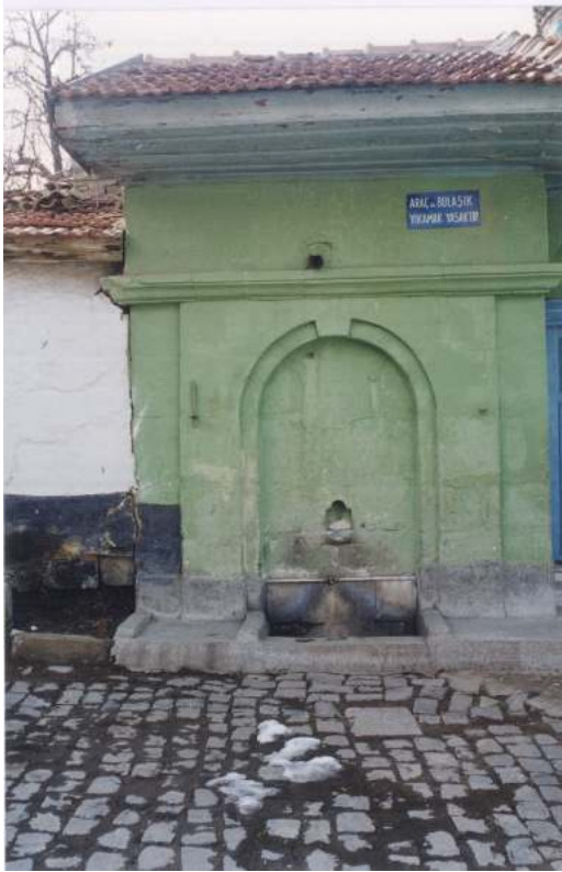
Resim No: 26 Kara Katip Çeşmesi Ön Görünüş
