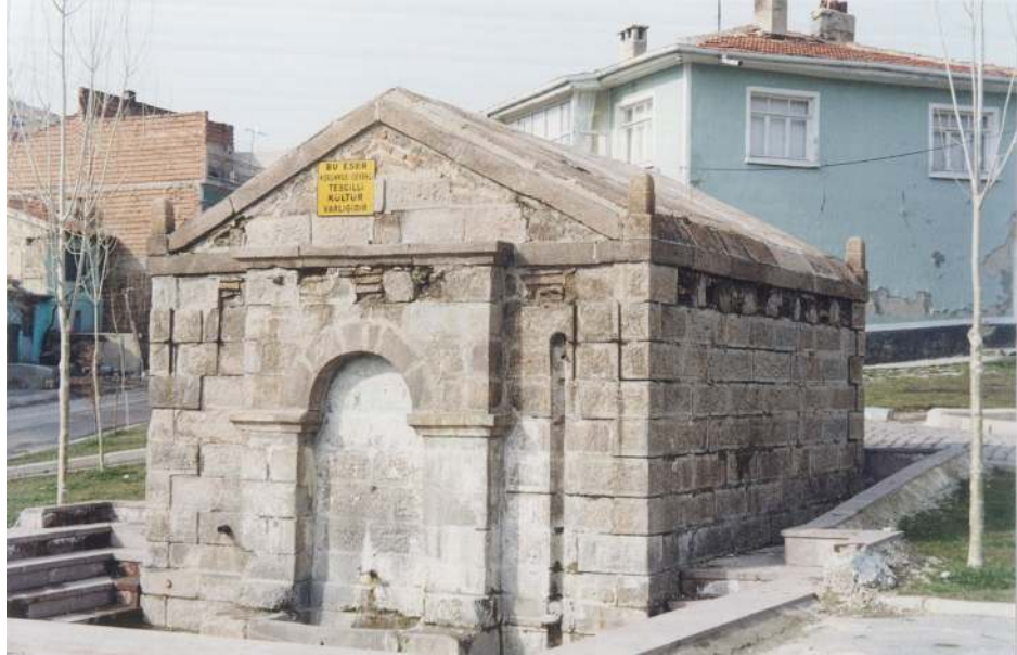
Resim No: 81 Yeni Çeşme Yan Görünüş
