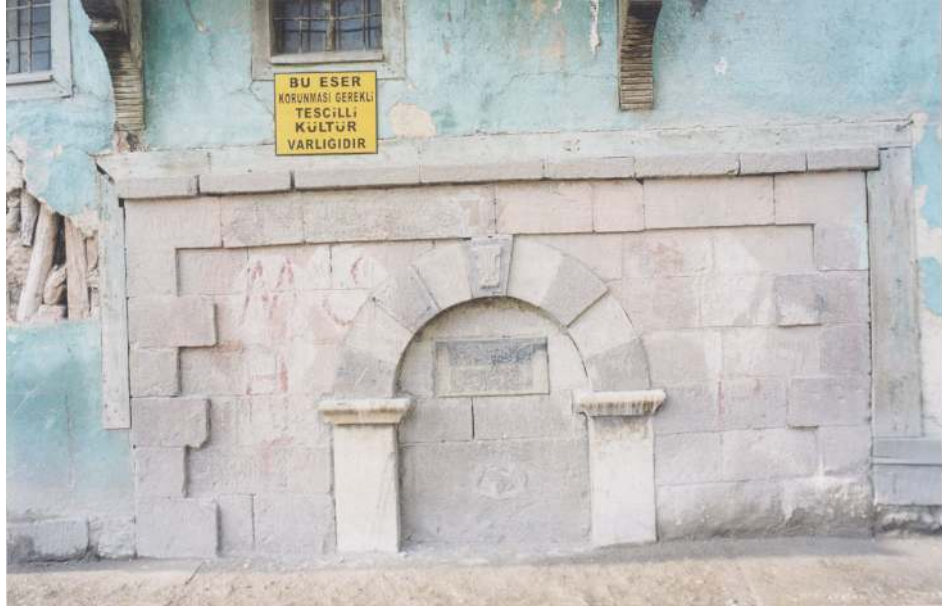
Resim No: 60 Sülüm 2 Çeşmesi Ön Görünüş
