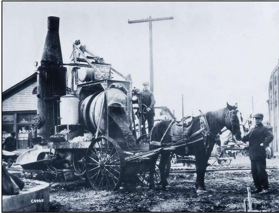
Şekil 3.1. At arabasıyla taşınan ilk hazır beton
