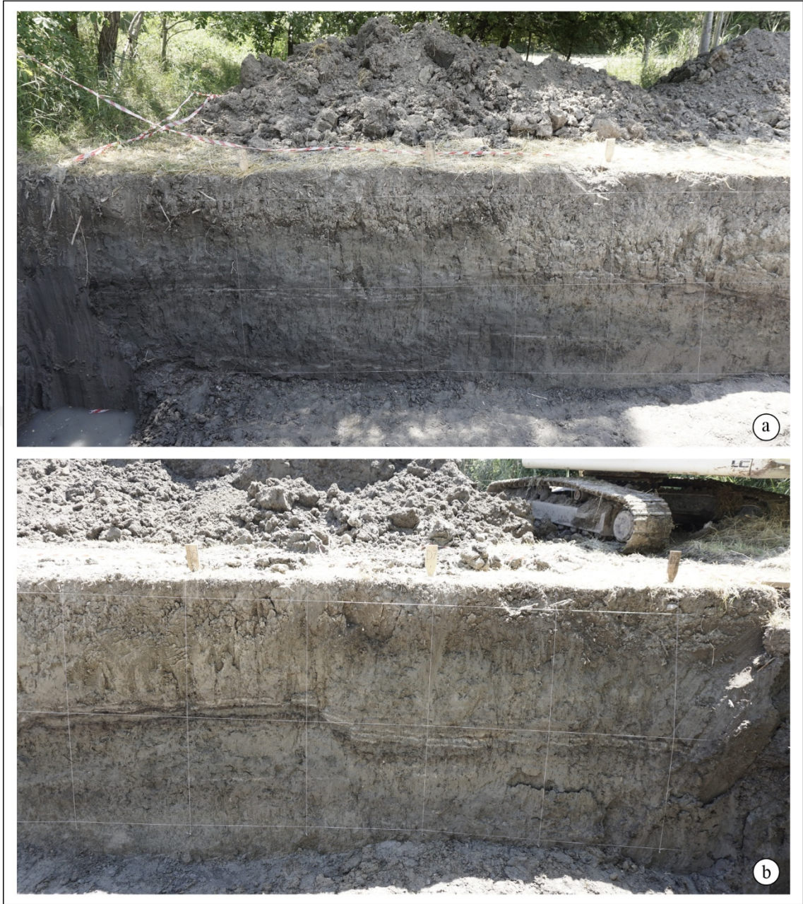
Şekil 3.4. Hendek duvarının temizlenip, karelajlanarak fotomozaik için fotoğraflandırılmaya uygun halleri ( a batı duvarı, b doğu duvarı)
