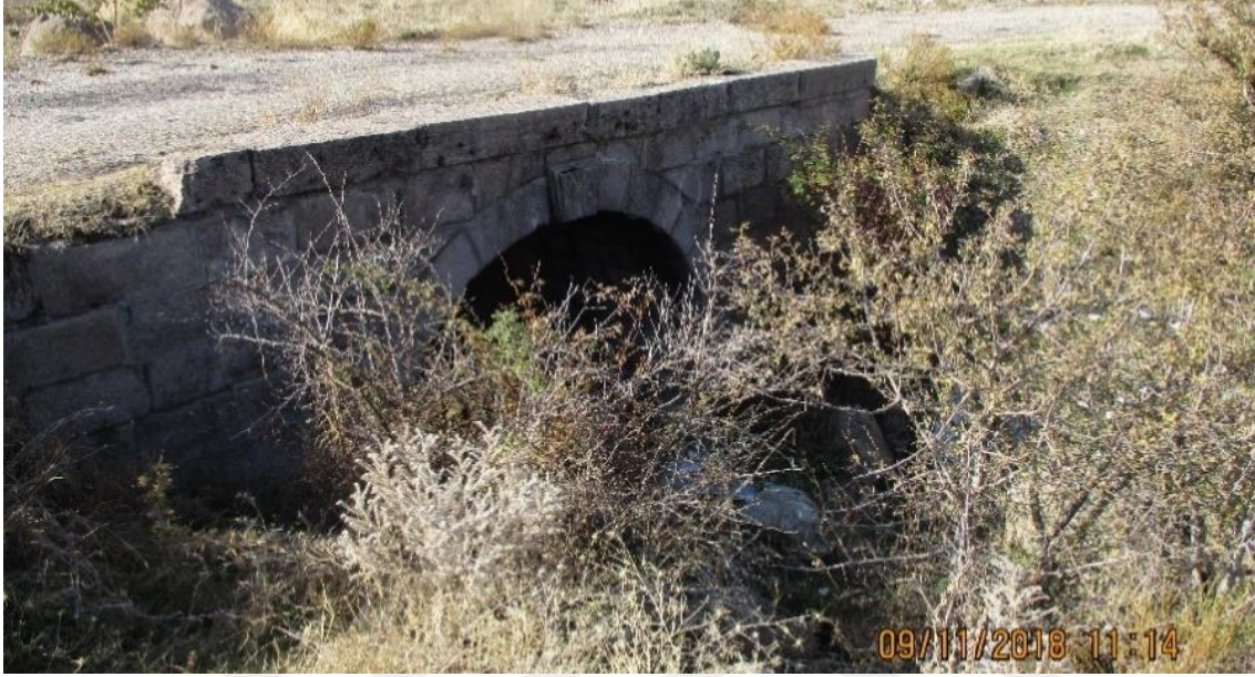
Resim 4.15 Kışlacık Köprüsü ön cephe.
