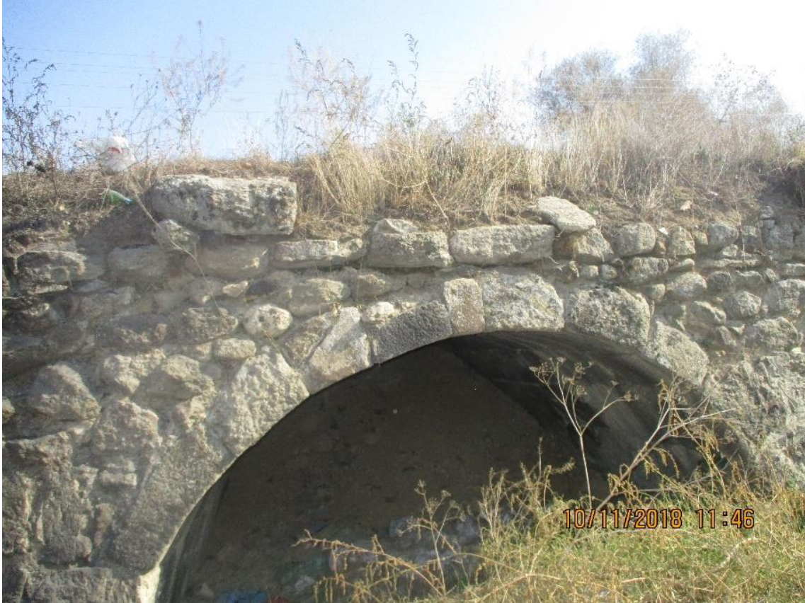
Resim 4.30 İkigöz Köprüsü doldurulmuş kemer görünümü.
