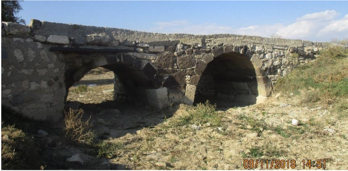
Resim 4.66 Yunuslar Ağılı Köprüsü.
