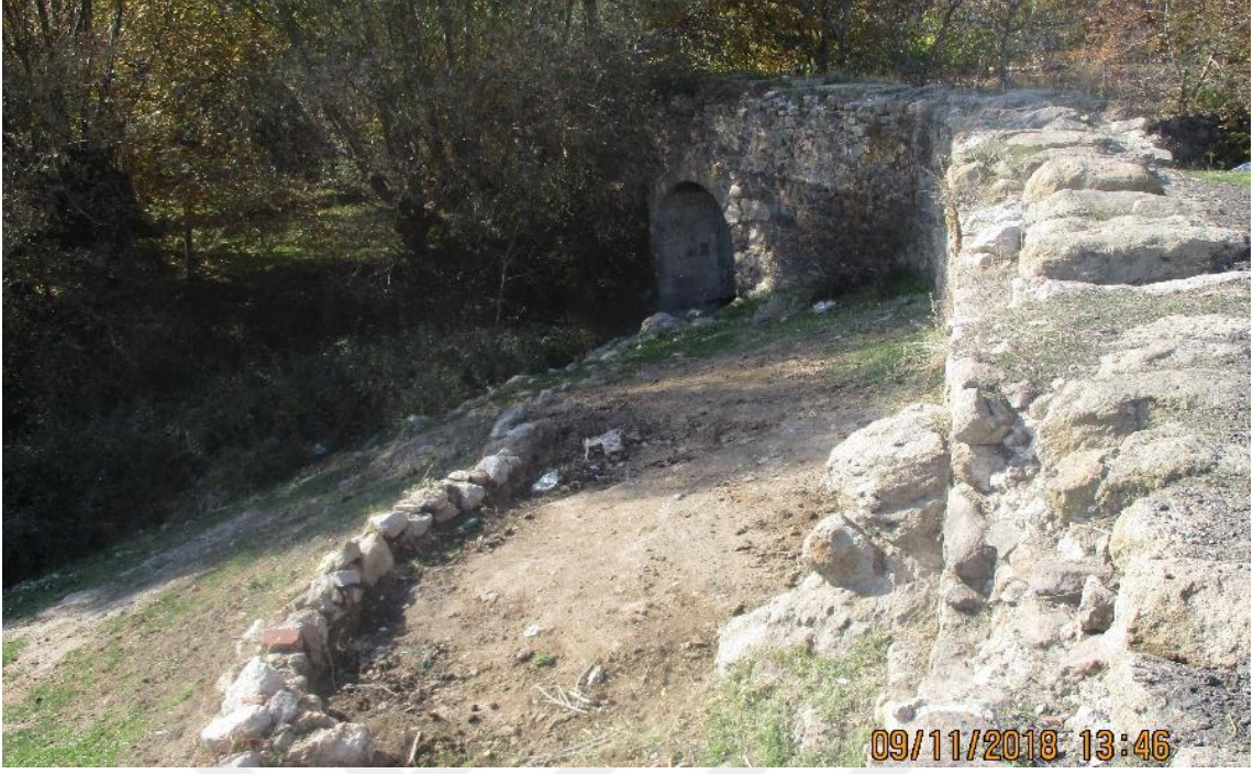
Resim 4.21 Kışlacık Su Yolu Köprüsü 2.
