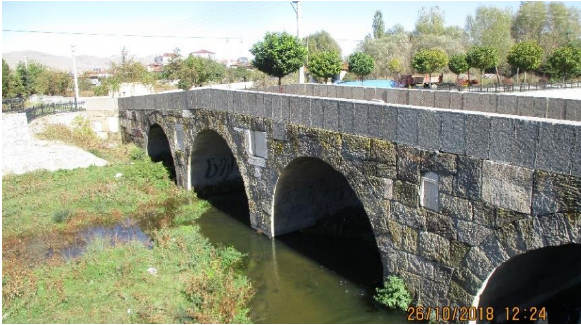
Resim 4.49 Dörtgöz Köprüsü batı yüzeyi görünümü.
