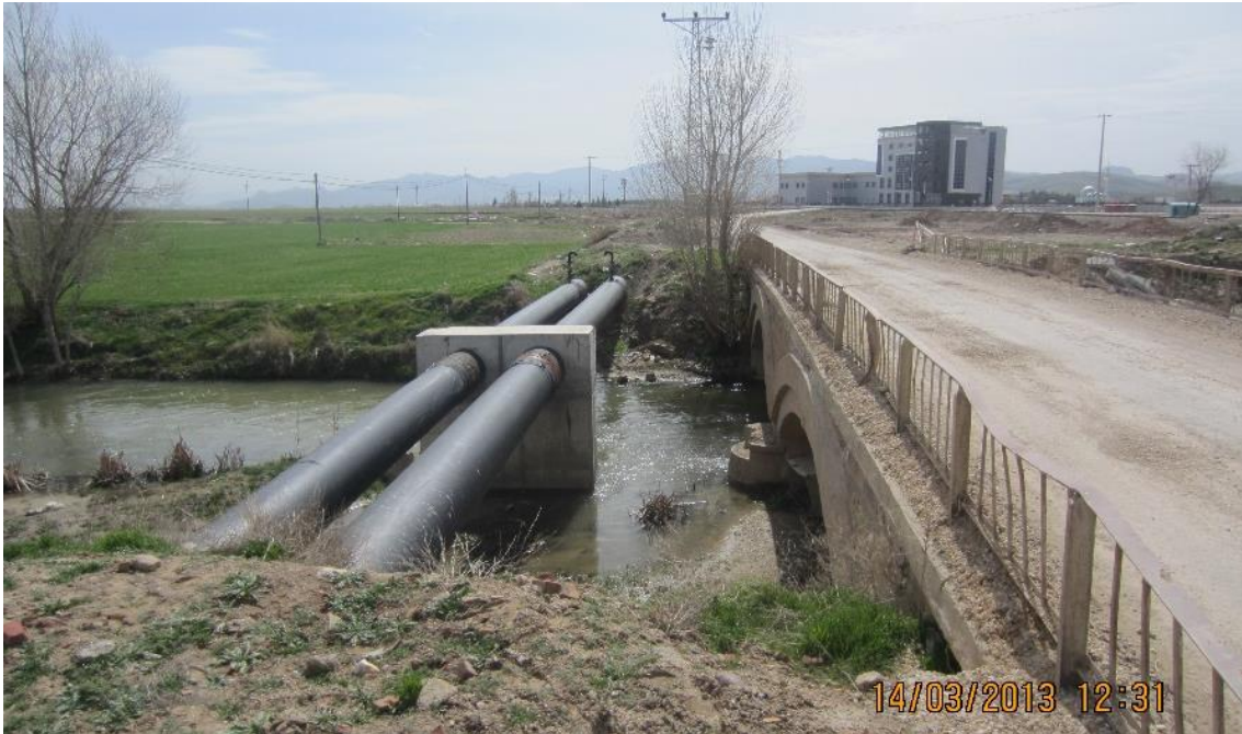
Resim 4.23 Araplı Köprüsü ön cephe (KGM).
