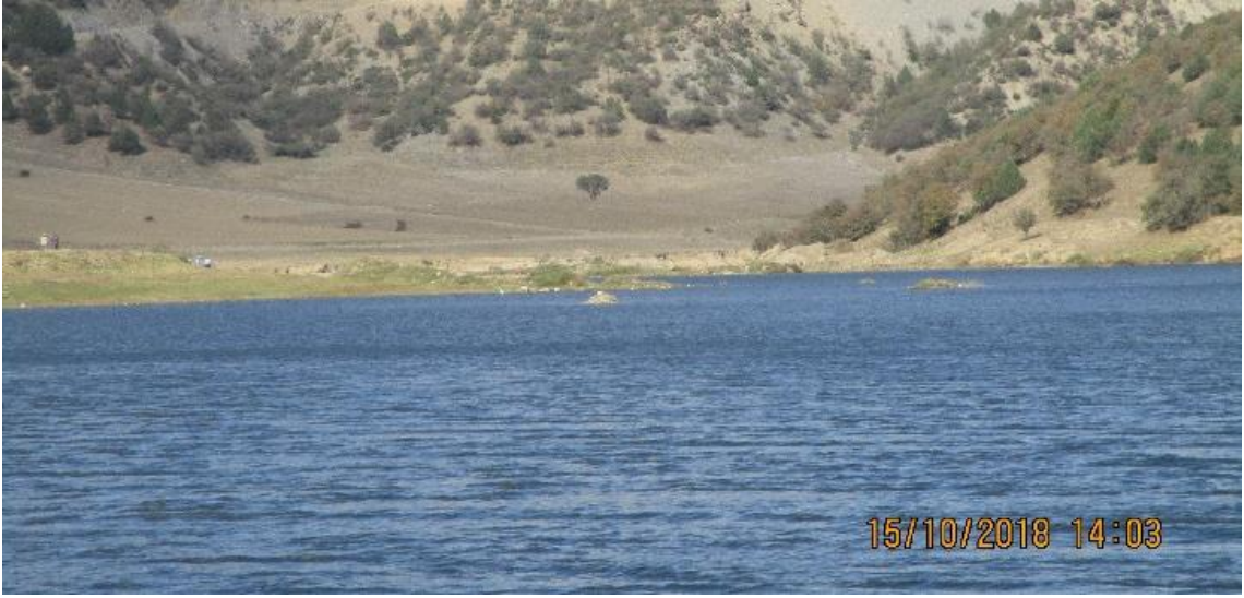
Resim 4.79 Tahta Köprüsünün bulunduğu dikili taş ve barajın görünümü.
