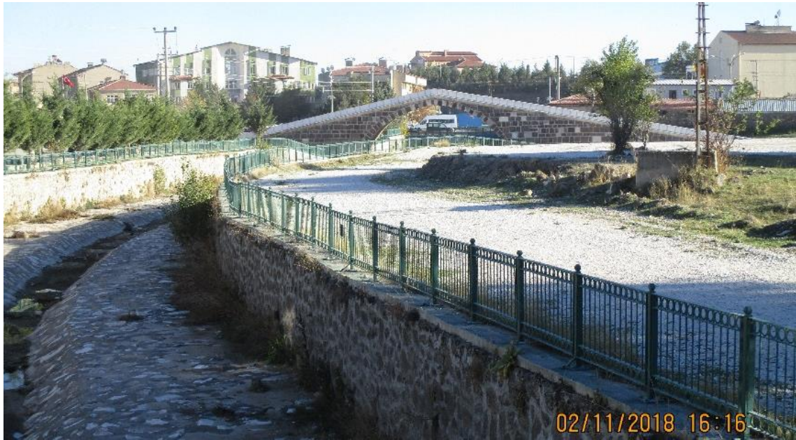
Resim 4.55 Koca Köprü restorasyon sonrası görünümü.
