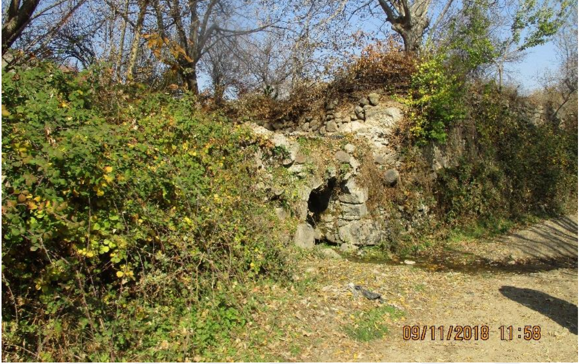
Resim 4.22 Kışlacık Su Yolu Köprüsü 3.
