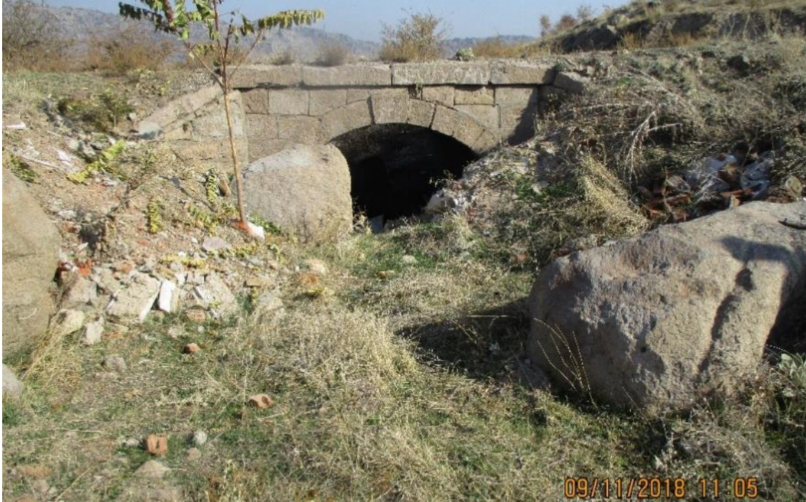
Resim 4.16 Kışlacık Köprüsü arka cephe.
