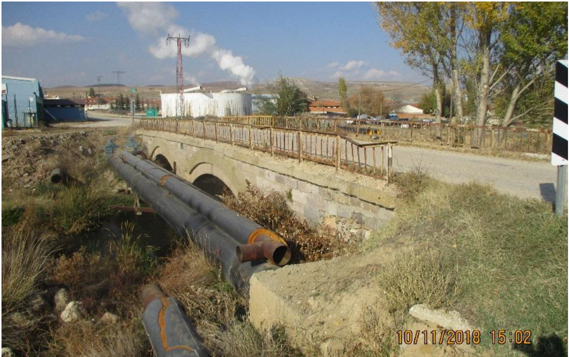
Resim 4.24 Araplı Köprüsü arka cephe.
