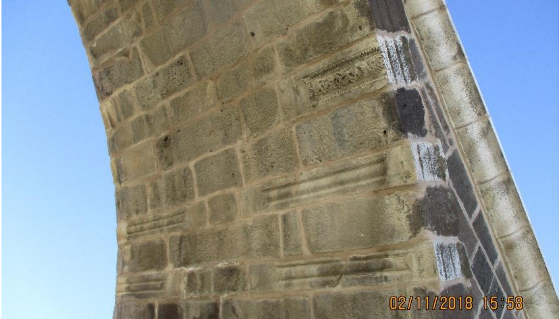
Resim 4.57 Koca Köprü devşirme malzeme görünümü.
