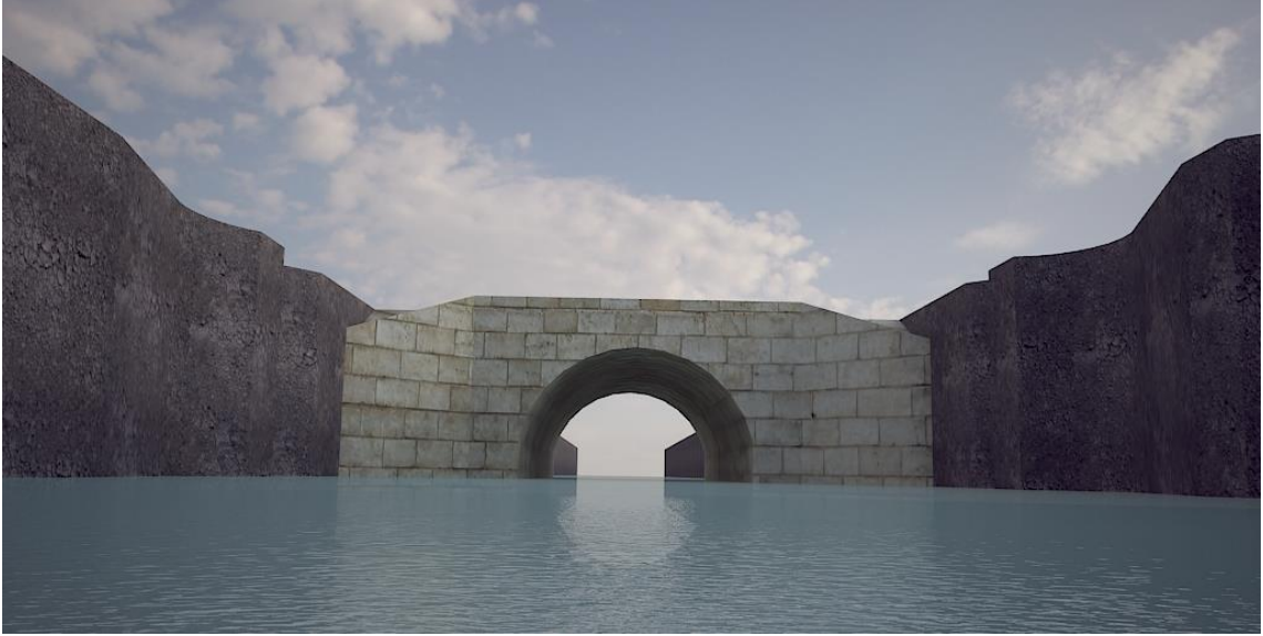
Şekil 4.13 Kışlacık Köprüsü 3D Modellemesi arka görünüş.
