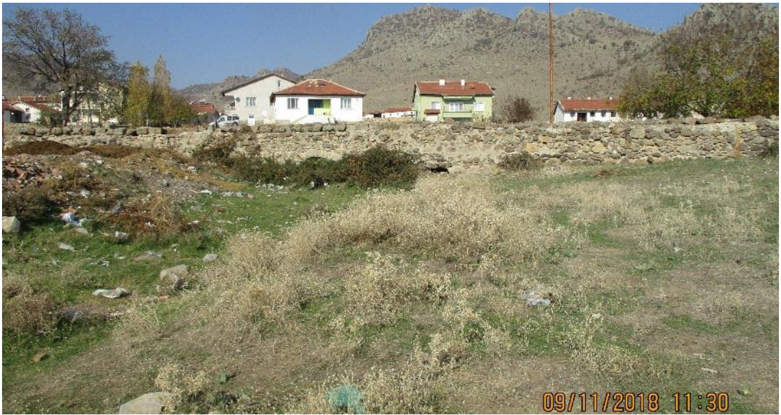
Resim 4.19 Kışlacık Su Yolu Köprüsü 1.
