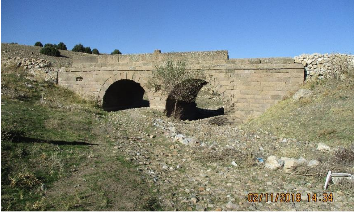
Resim 4.58 Başkonak Köprüsü arka cephe.
