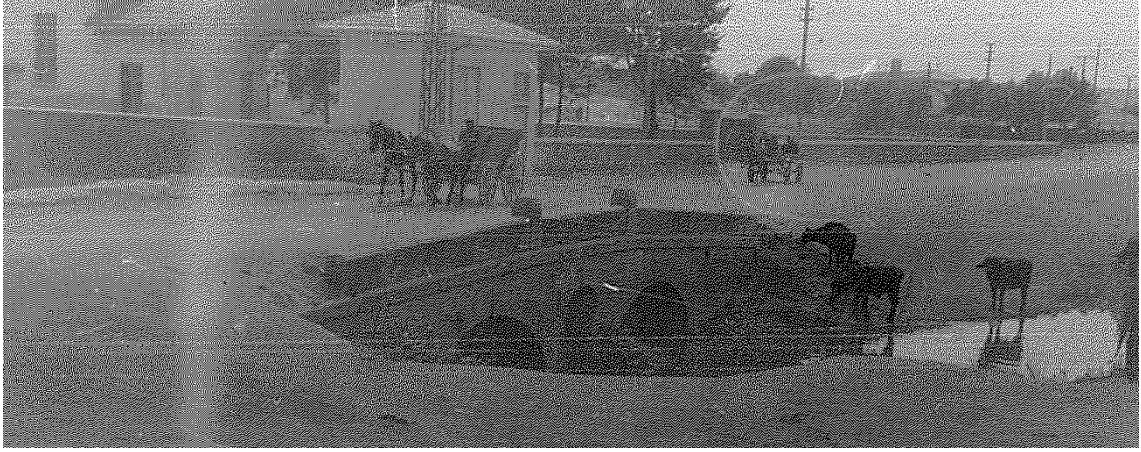
Resim 4.83 Mezbaha Köprüsü ön cephe (KGM).
