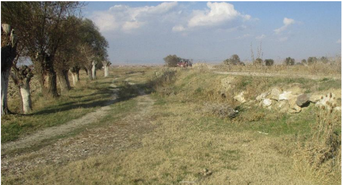
Resim 4.69 Yunuslar Ağılı Köprüsü yan yüzeylerin ve kemerlerin görünümü.
