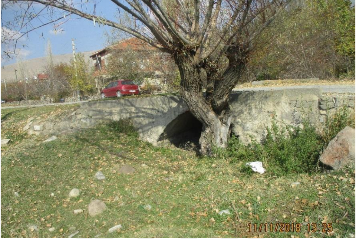
Resim 4.36 Başağaç Giriş Köprüsü güney bölümü.
