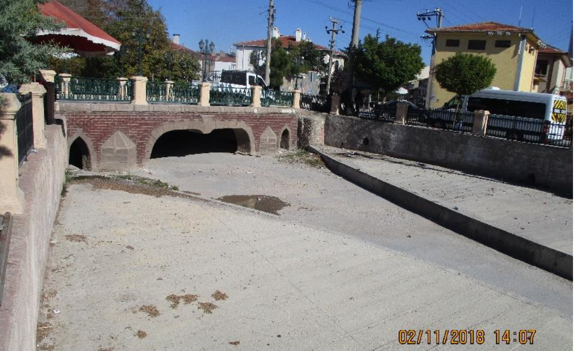
Resim 4.82 Emirdağ İçi (Okul) Köprüsü yerine yapılan betonarme köprü.
