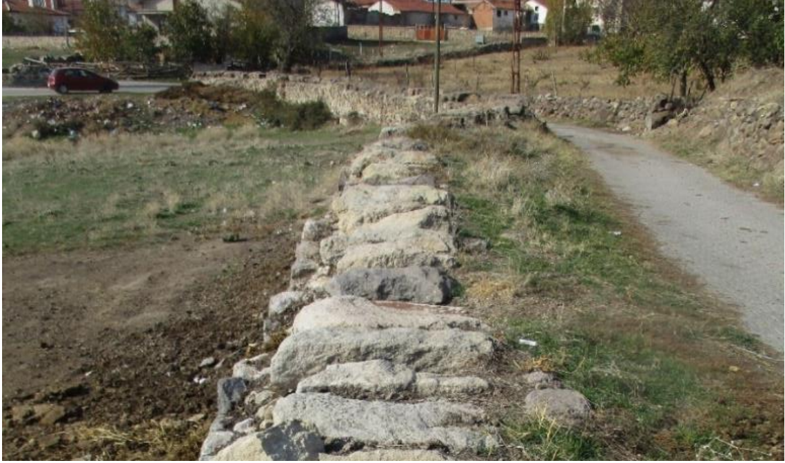
Resim 4.20 Kışlacık Su Yolu Köprüsü 1 üstten görünümü.
