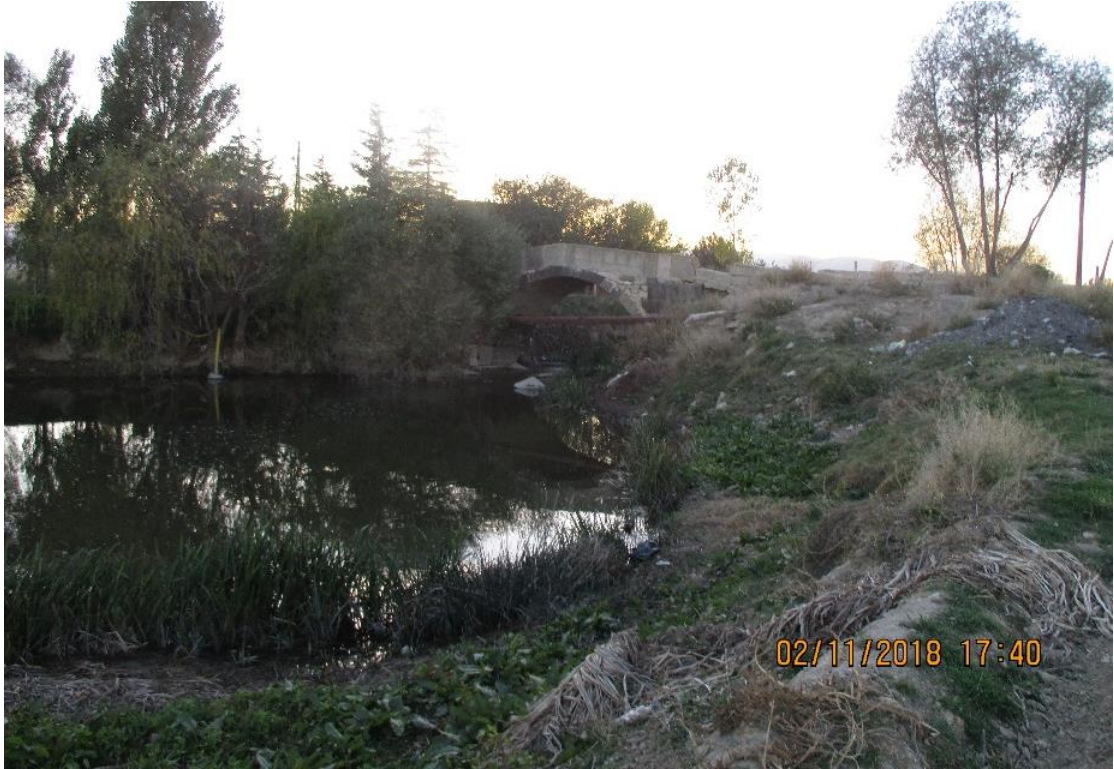
Resim 4.7 Kanlı Gölet Köprüsü.
