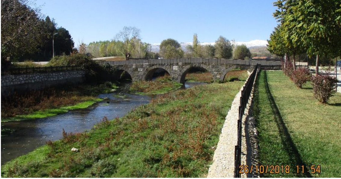
Resim 4.48 Dörtgöz Köprüsü doęu yüzeyi görünümü.
