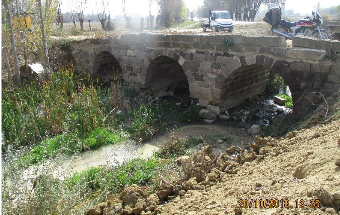
Resim 4.37 Balmahmut Köprüsü arka cephe görünüşü.
