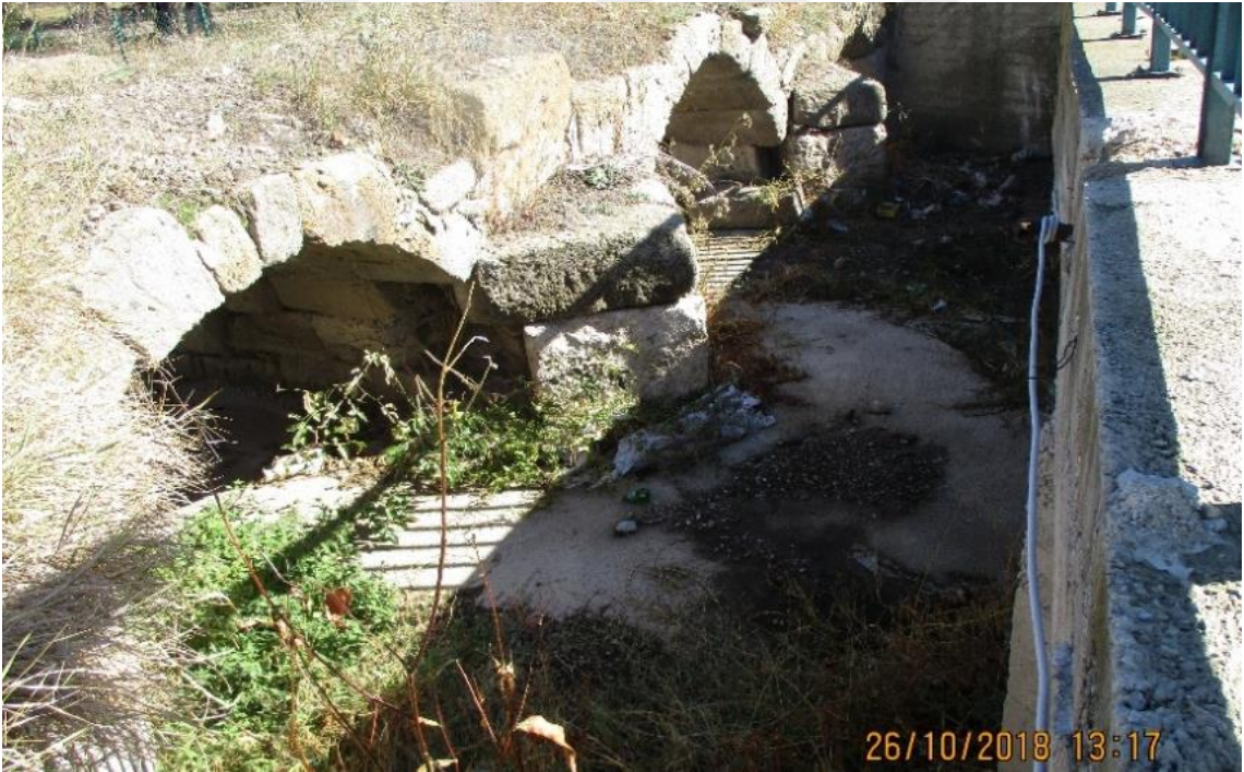
Resim 4.53 Üçgöz Köprüsü güney bölümü.
