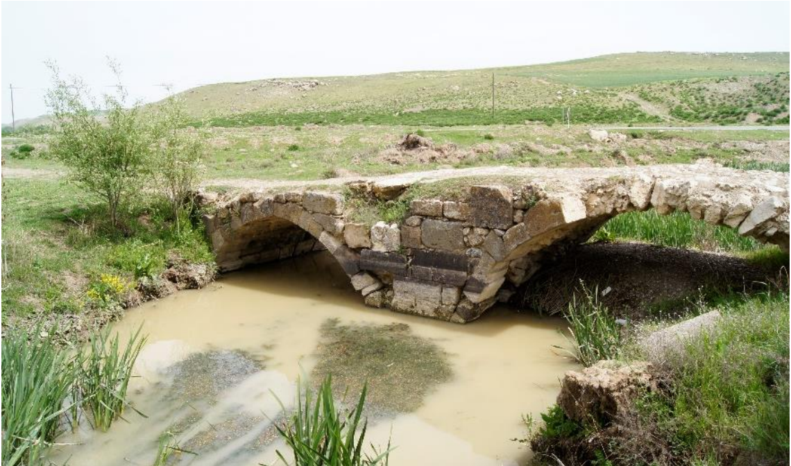
Resim 4.65 Kurt Musa Köprüsü batı bölümü (KGM).
