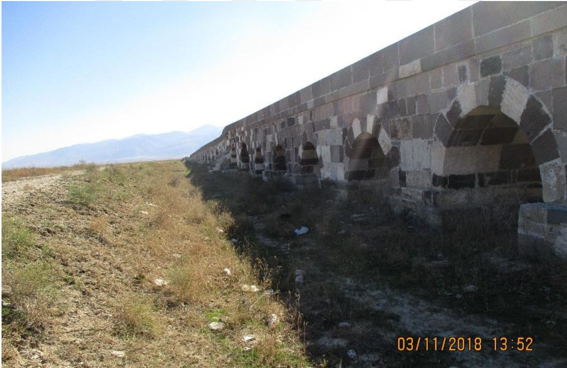
Resim 4.45 Kırkgöz Köprüsü arka cephe.
