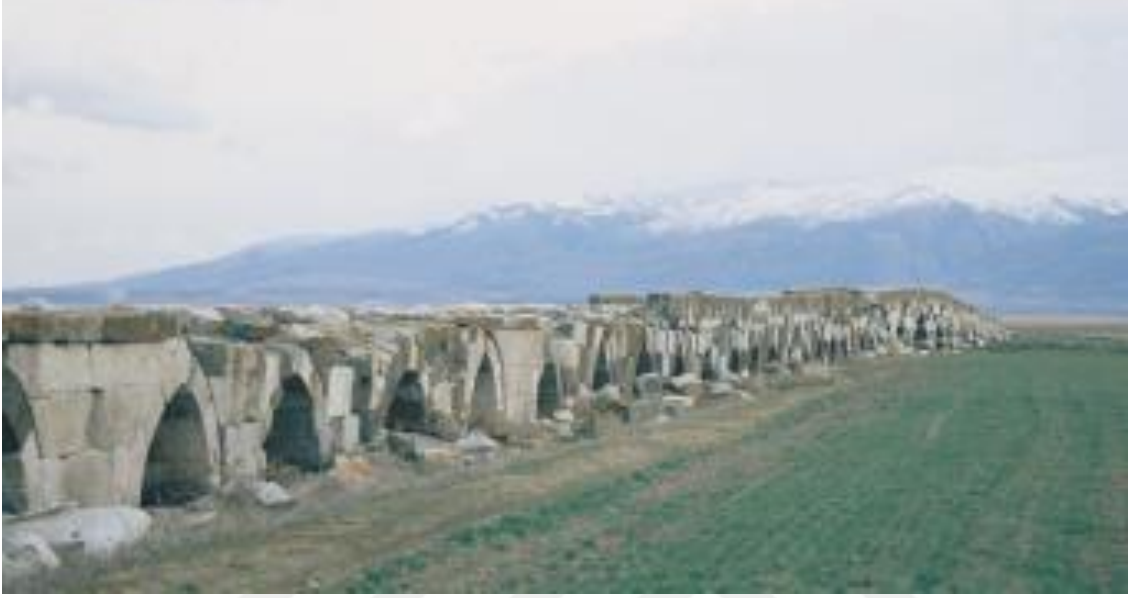
Resim 4.43 Kırkgöz Köprüsü restorasyon geçirmeden önceki görünümü (Üyümez ve Kaya).
