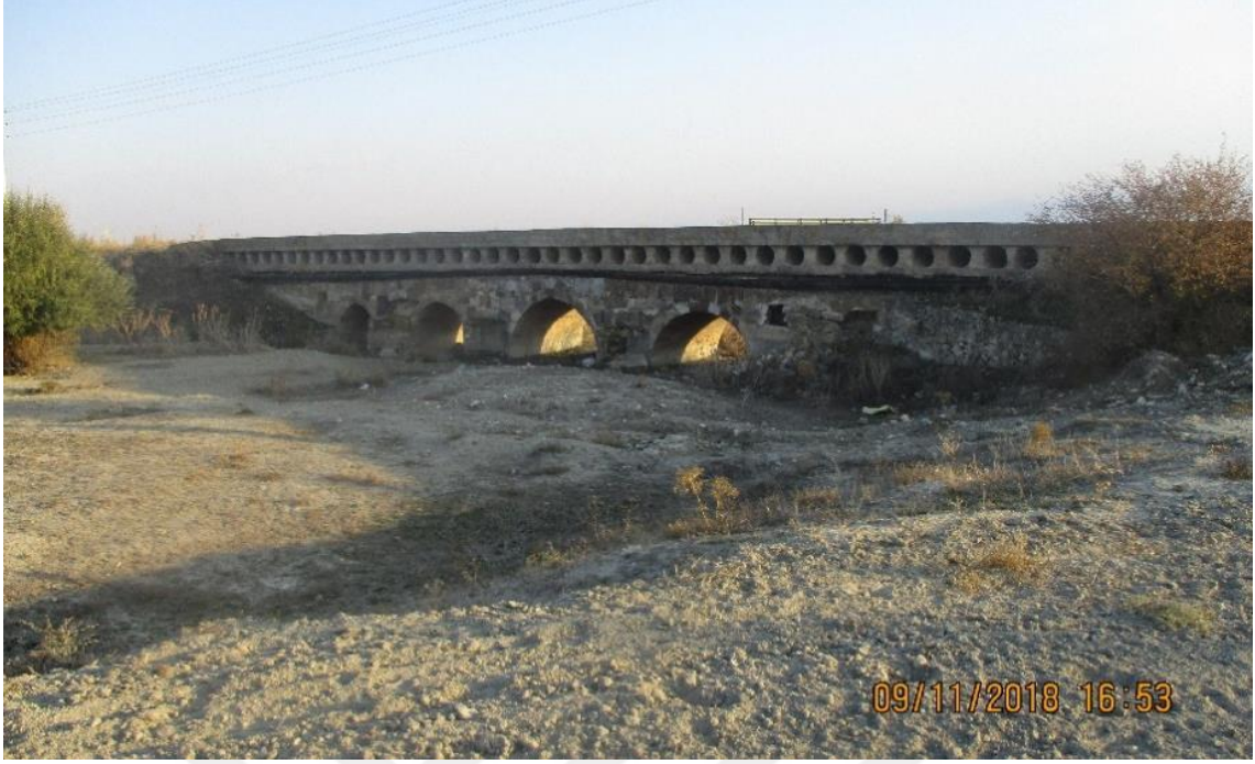
Resim 4.62 Taş Köprü doğu yüzeyi.
