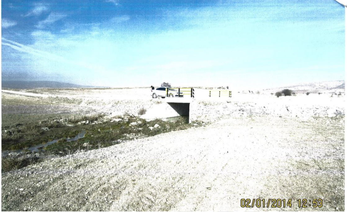
Resim 4.85 Oğulbeyli Köprüsü yerine yapılan betonarme köprü (KGM).
