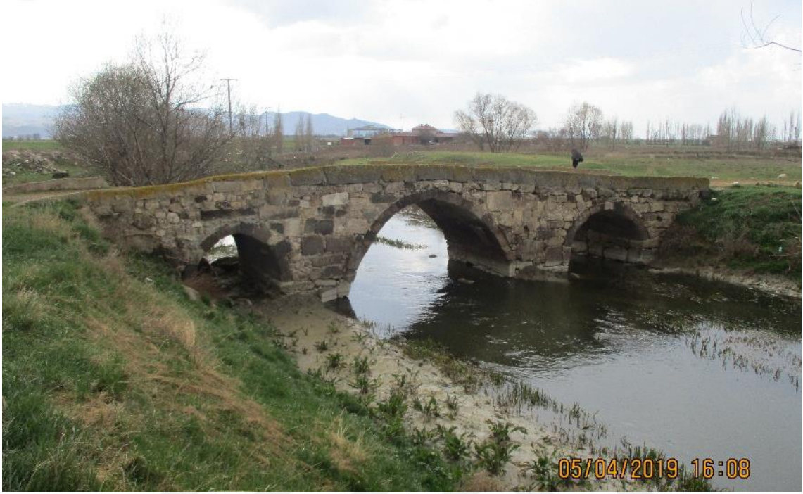
Resim 4.18 Çenkçi Köprüsü arka cephe.
