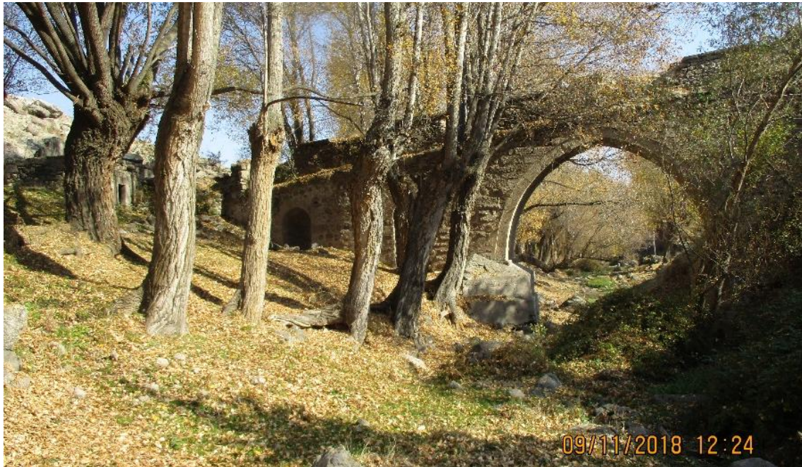
Resim 4.11 Kadınana Köprüsü su deposu ve köprünün betonarme ayaklarının görünümü.
