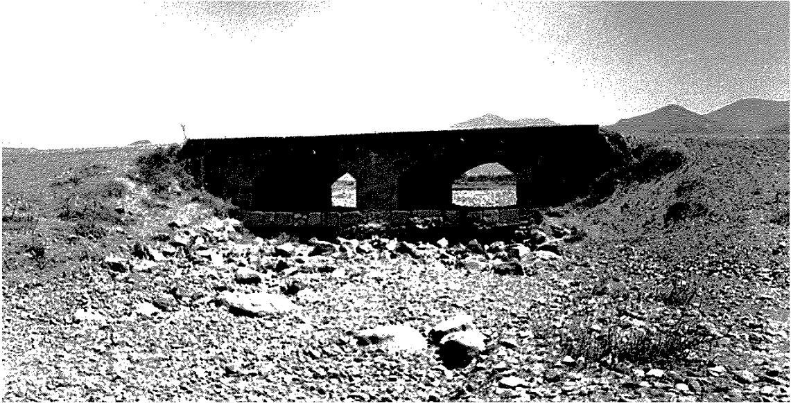
Resim 4.76 Kuruçay Köprüsü (KGM).
