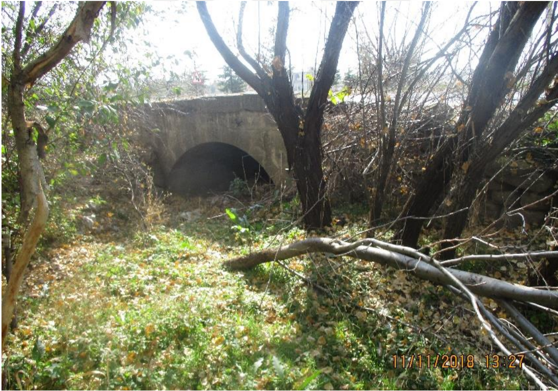
Resim 4.35 Başağaç Giriş Köprüsü kuzey bölümü.
