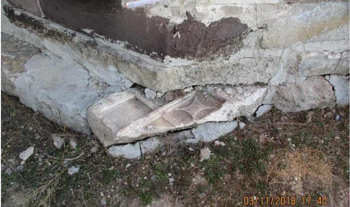
Resim 4.44 Kırkgöz Köprüsü ayaklarında gözüken devşirme malzemeler.
