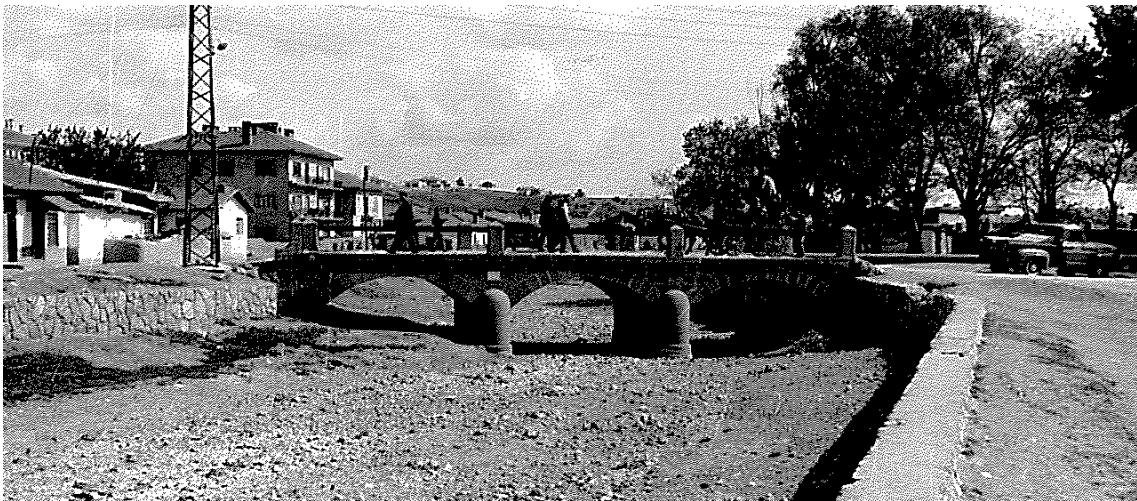
Resim 4.80 Emirdağ İçi (Okul) Köprüsü ön cephe (KGM).
