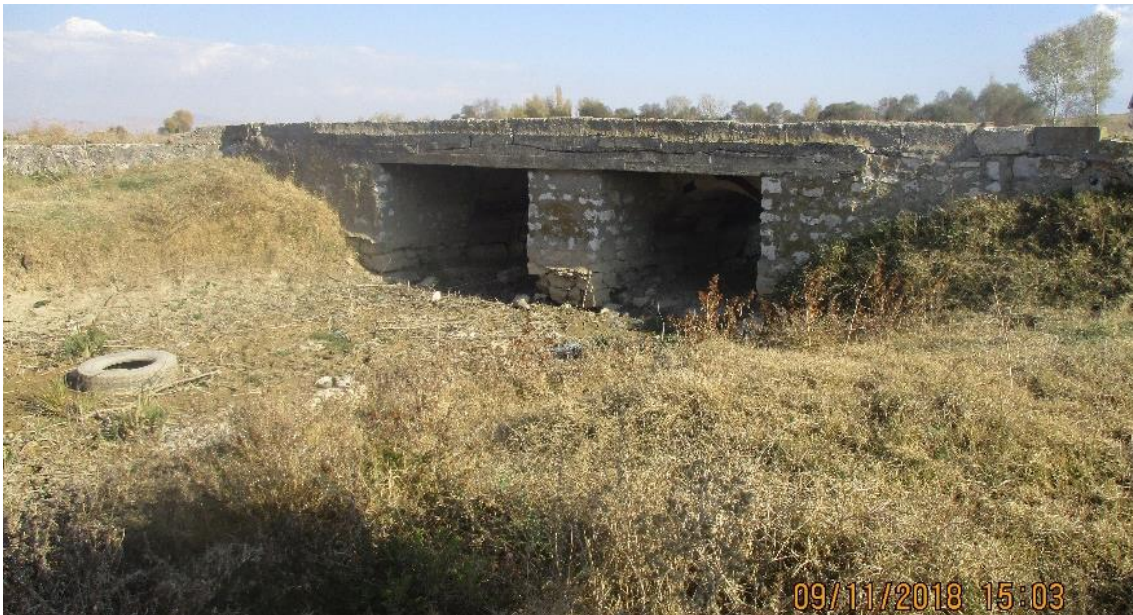
Resim 4.67 Yunuslar Ağılı Köprüsü betonarme ek görünümü.
