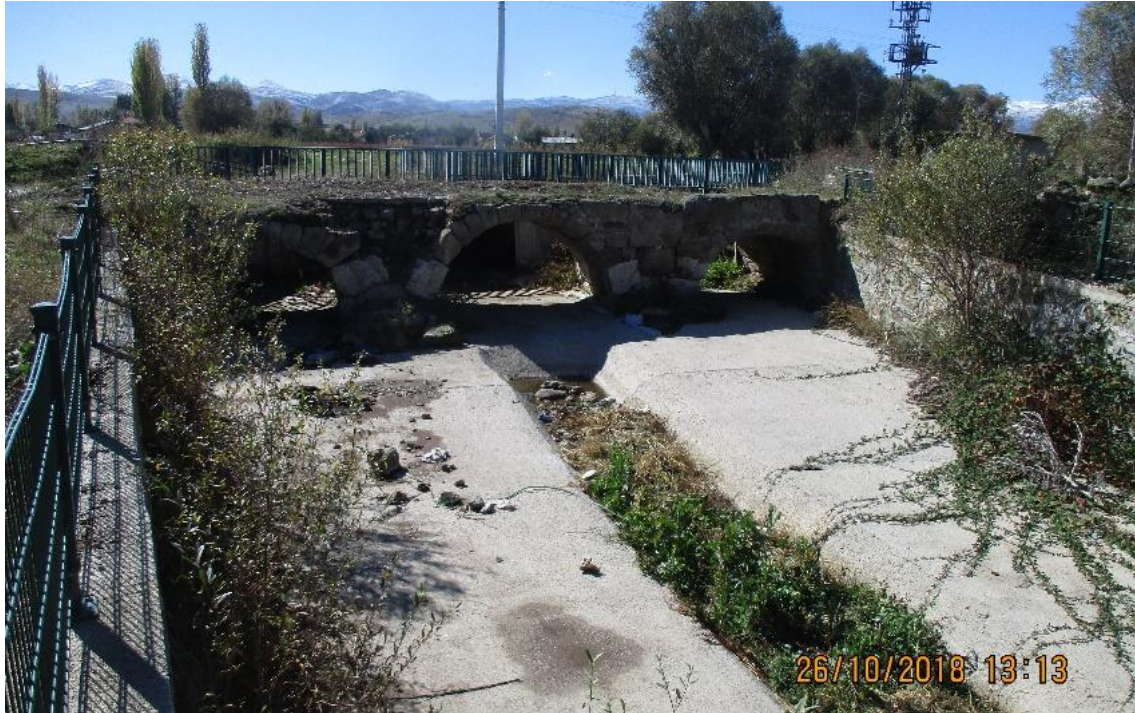
Resim 4.51 Üçgöz Köprüsü kuzey bölümü.
