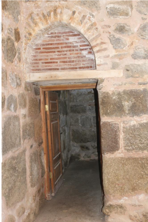
Fotoğraf 3.24. Kuzey- doğu mekanın kapı alınlık kemer detay (Mert Keke,2018)
