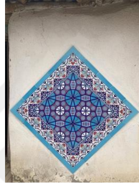
Resim 45. Duvar Çini Detayı
