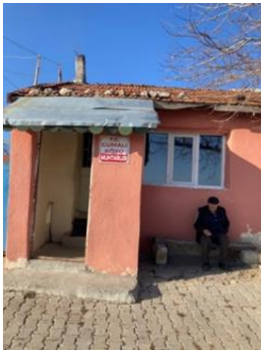
Resim 107. Oda Ön Görünüş-1
