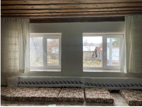
Resim 96. Oda Güney Cephe
