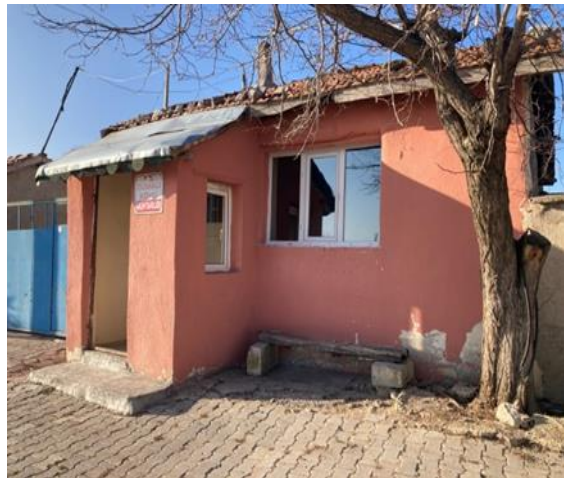
Resim 108. Oda Ön Görünüş-2
