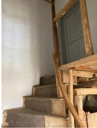
Resim 77. Esas Oda Kapısı
