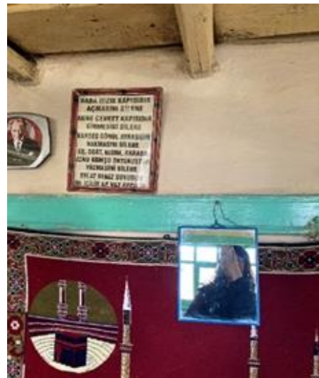
Resim 132. Kuzey Duvarın Sağ Kısmı
