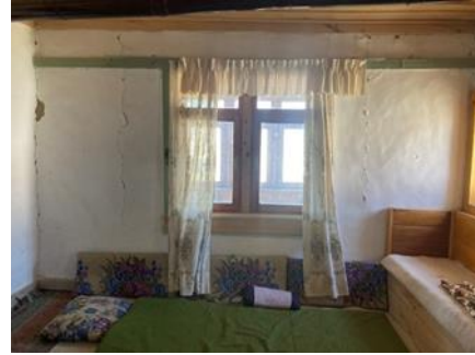
Resim 68. Oda Güney Duvarı
