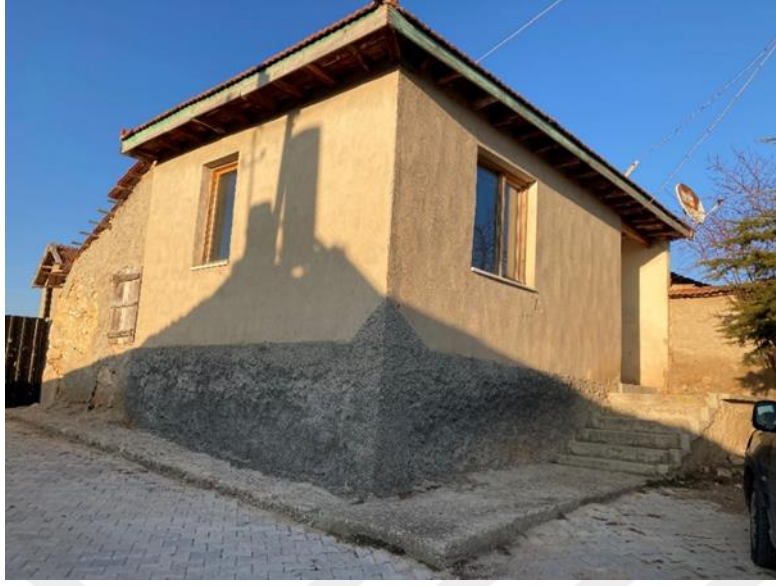
Resim 137. Oda Güney-Batı Cephe Görünüş
