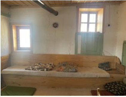
Resim 67. Oda Batı Duvarı
