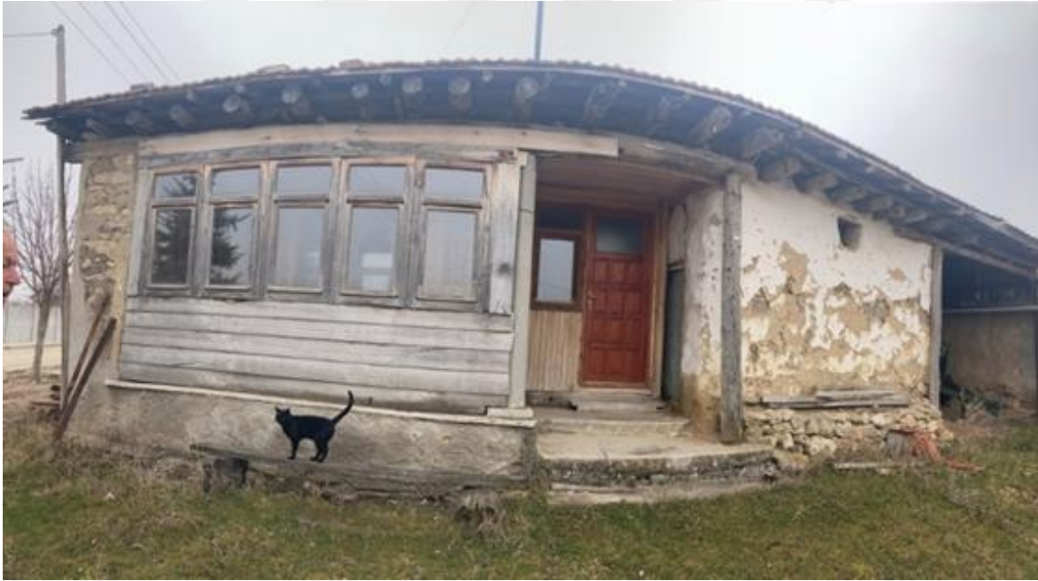
Resim 57. Kuzey Cephe Görünüşü
