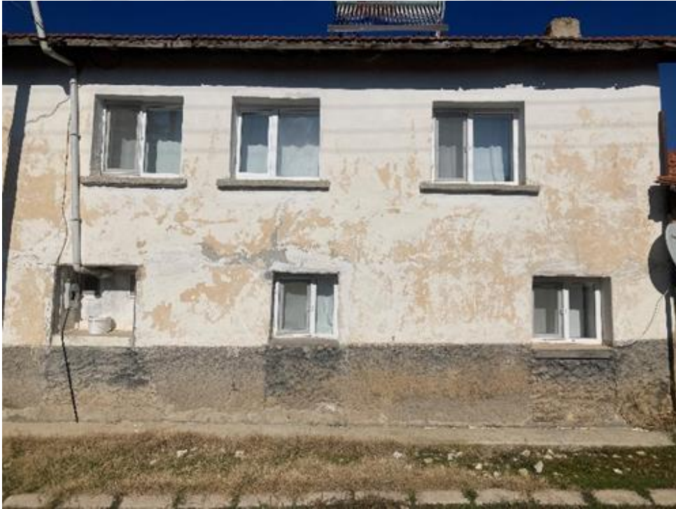
Resim 91. Oda Ön Görünüş
