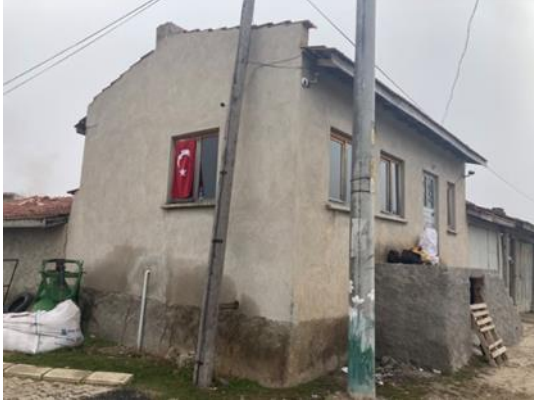
Resim 31. Odanın Kuzey-Batı Cephe Görünüş
