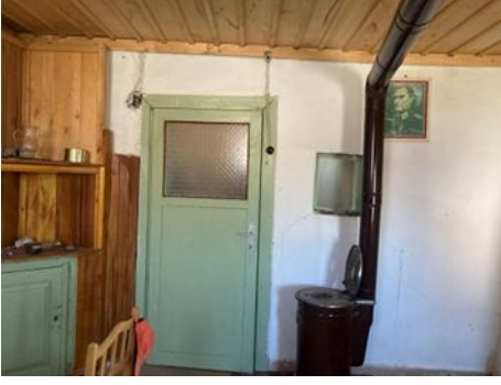
Resim 65. Oda Doğu Duvarı
