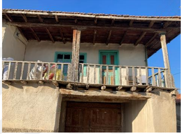
Resim 122. Güney Cephe Görünüşü
