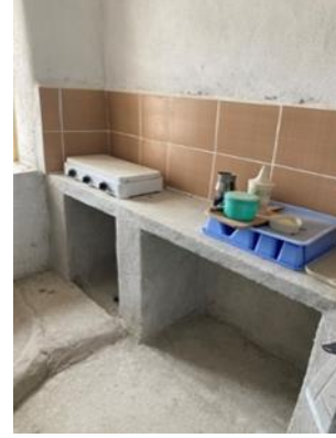
Resim 88. Mutfak Güney Duvarı
