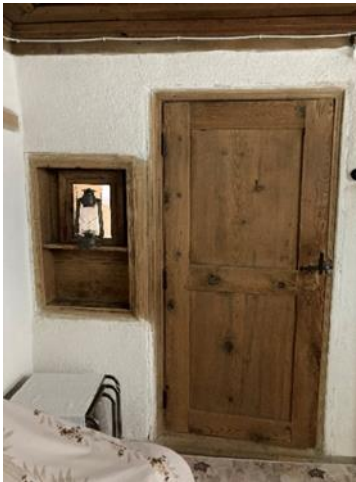
Resim 94. Oda Giriş Kapı
