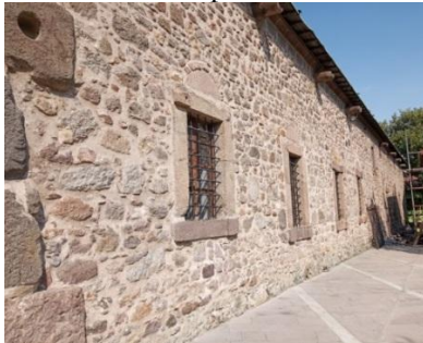
Resim 14. Ulu Cami Güney Cephe
