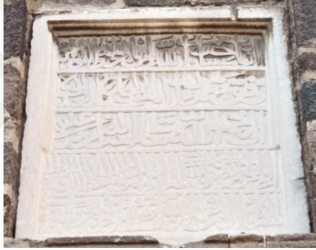
Resim 20. Ulu Cami Onarım Kitabesi
