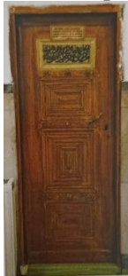
Resim 258. Mısri Camii’nin Minare Kapısı
