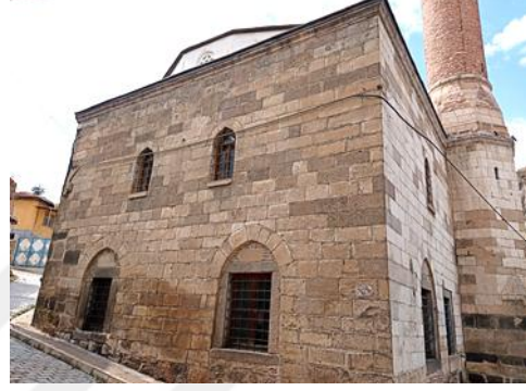
Resim 138. Ak Mescit Camii Güney Cephe
