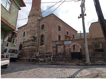
Resim 139. Ak Mescit Camii Doğu Cephe
