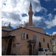
Resim 220. Mısri Camii Doğu Girişi ve Kuzey Cephe.
