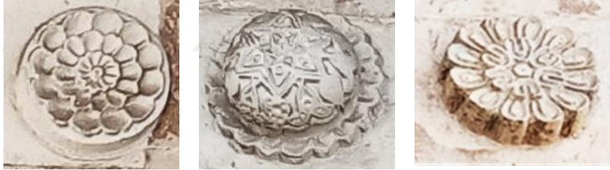
Resim 161. Gedik Ahmet Paşa Camii Kuzey Cephe Pencere Üstü Rozetlerden Örnekler
