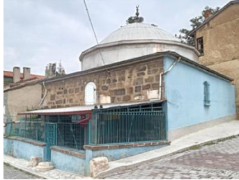
Resim 307. Tac Ahmet Camii Kuzey Cephe
