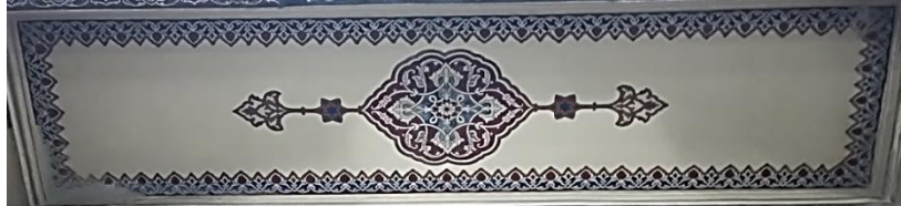
Resim 214. Gedik Ahmet Paşa Camii Bursa Kemerli Ahşap Gergileri Detay
