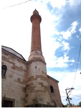
Resim 145. Ak Mescit Camii Minaresi
