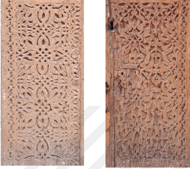
Resim 317. Burmalı Cami Kapı Kanatlarının Ortası
