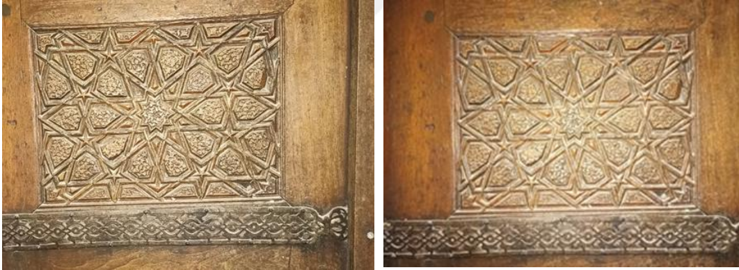
Resim 173. Gedik Ahmet Paşa Camii Kapısı Alt Tabla Detay
