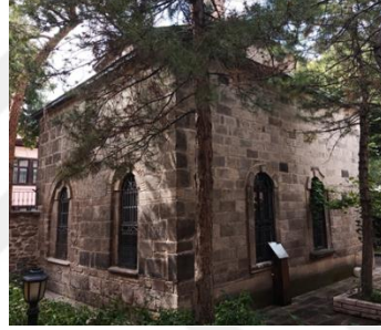
Resim 79. Kuyulu Cami Güneydoğu Cephe
