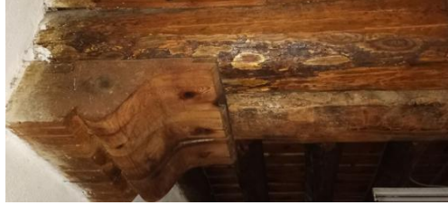
Resim 75. Ulu Cami Hatılları
