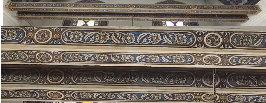
Resim 213. Gedik Ahmet Paşa Camii Bursa Kemerli Ahşap Gergileri Detay
