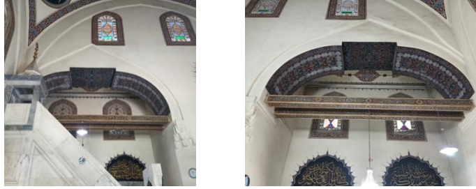
Resim 210. Gedik Ahmet Paşa Camii Eyvan Geçişlerinde Yer Alan Bursa Kemerleri
