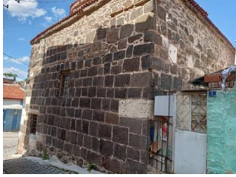
Resim 85. Kubeli Camii Batı, Güney Cephe ve Batı Cephe Pencere Lentosundan Detay
