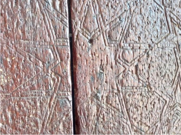
Resim 91. Kubeli Camii Kapı On Kollu Yıldız Detayı
