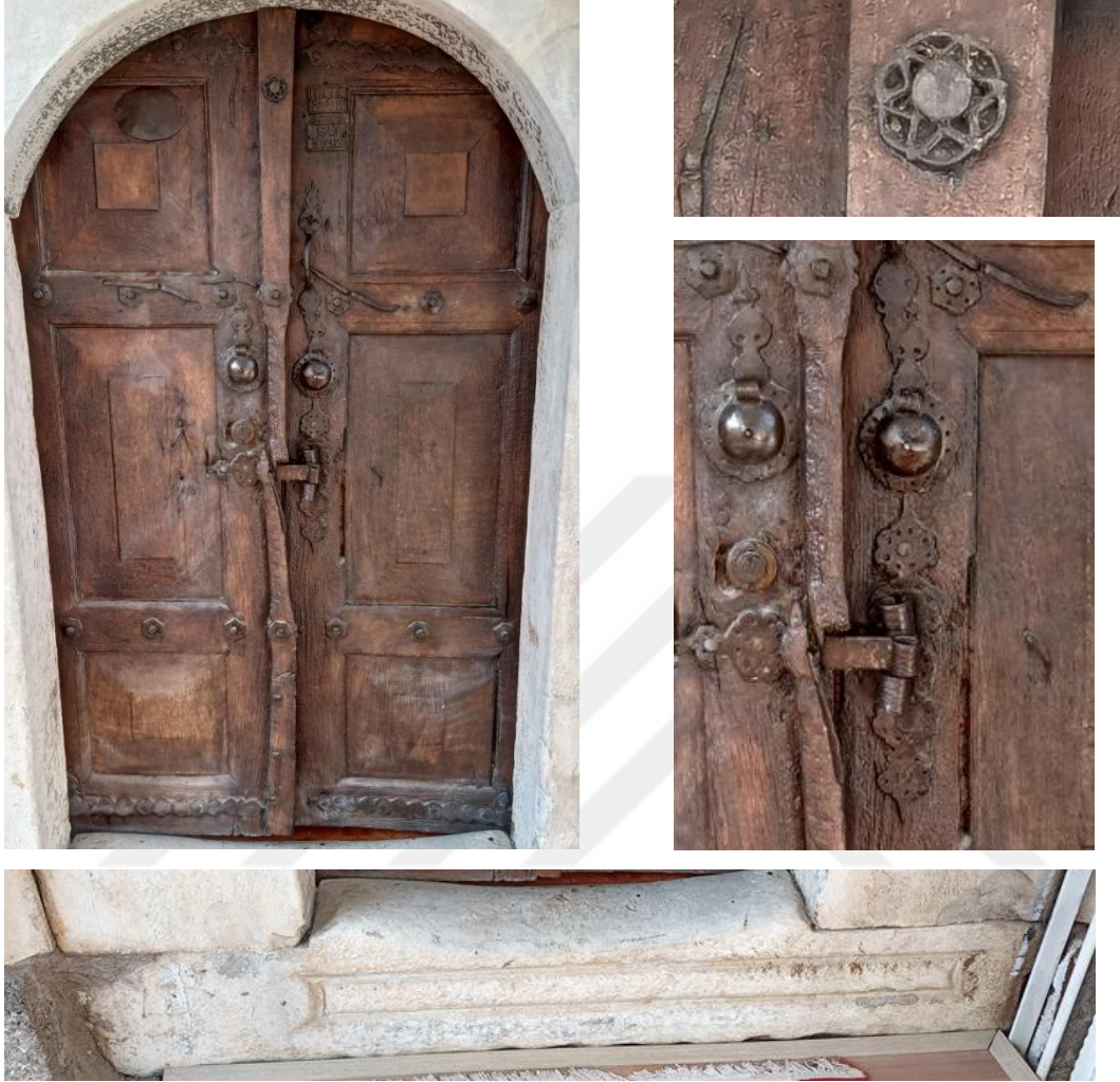
Resim 124. Kabe Mescit Camii Kapı Detayları
