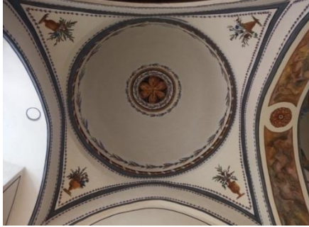
Resim 293. Arap Mescit Camii, Son Cemaat Mahallindeki Doğu Kubbe
