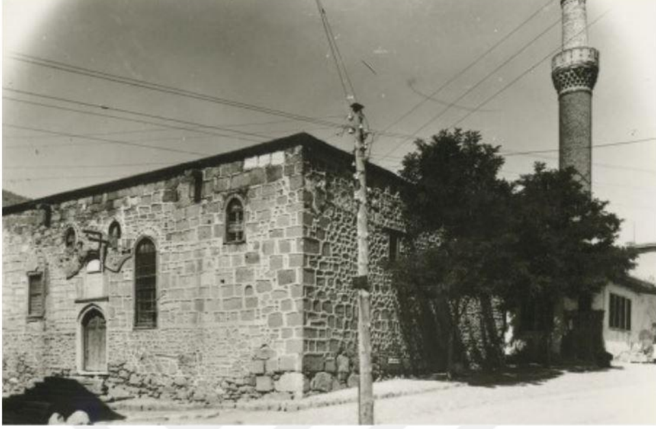
Ek 1: 1947 Yılında Başlayan Restorasyon Çalışmalarından Önce Cami ve Minarenin Durumunu Gösteren Eski Fotoğraf
