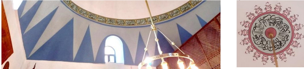
Resim 135. Kabe Mescit Camii'nin Kubbe Kenar Detayı
