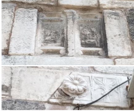
Resim 86. Kubeli Camii Duvarlarından Devşirme Detaylar
