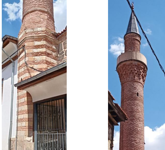
Resim 290. Arap Mescit Camii Minare Detay
