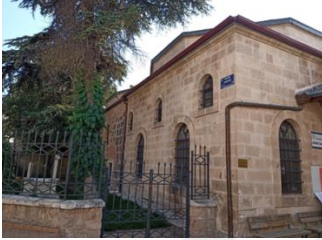
Resim 219. Mısri Camii Doğu Cephe
