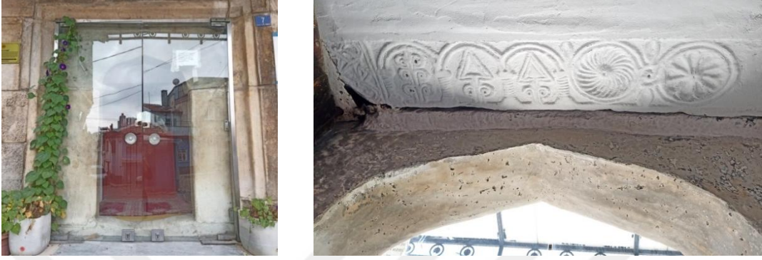
Resim 88. Kubeli Camii Girişi ve Devşirme Detay
