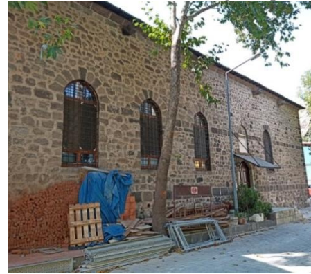
Resim 13. Ulu Cami Doğu Cephe
