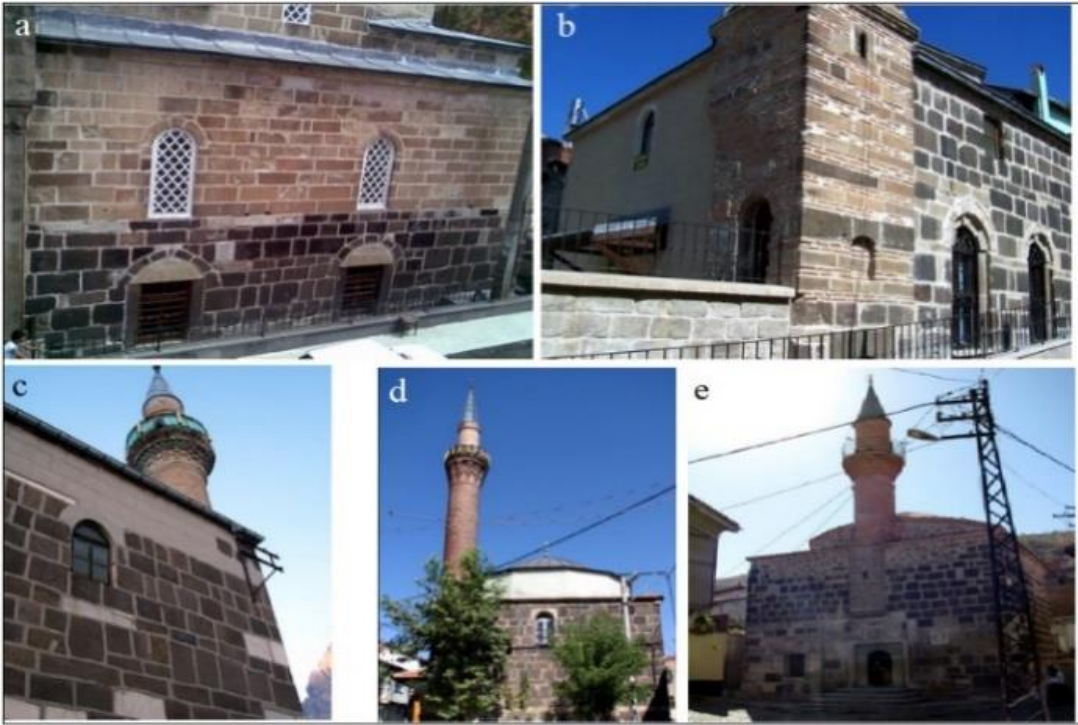
Resim 3.3 İscehisar andezitlerin Afyonkarahisar yöresinde tarihi yapılarda kullanımına örnekler: a) Otpazarı Cami (1590 öncesi), b) Kuyulu Cami (1900), c) Kâbe Mescit Cami (1397), d) Arapmescit Cami (1800 öncesi), e) Kubbeli cami.
