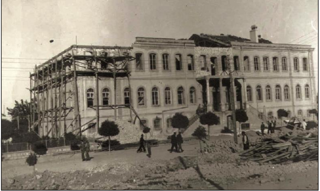
Şekil 14. 1934 Yılında Yapılan Tadilat Çalışmaları Sırasında Çatı Değiştirildi ve Balkonlu Kısım Kaldırıldı.
