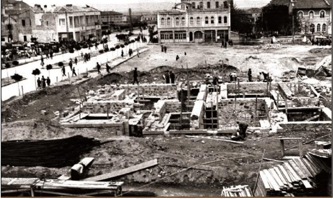
Şekil 10. Binanın İnşaat Çalışmaları,16/05/1938, PTT Arşivi
