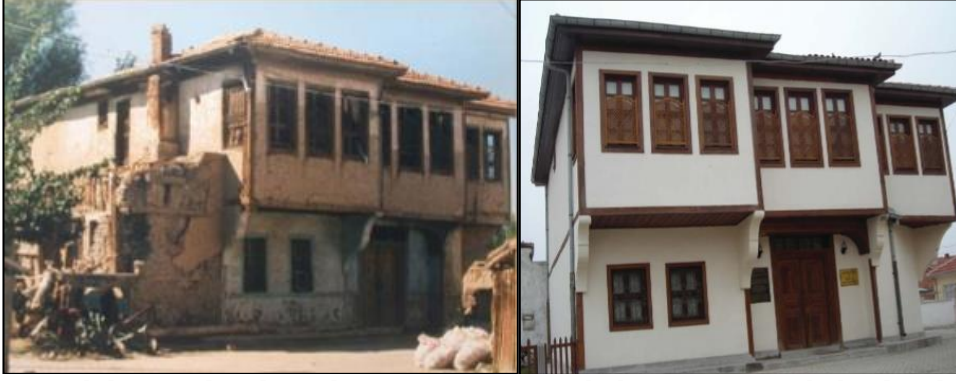
Şekil 33. Şuhut Hacıvelioğlu Konağı (Atatürk Evi) Restorasyon Öncesi ve Sonrası
