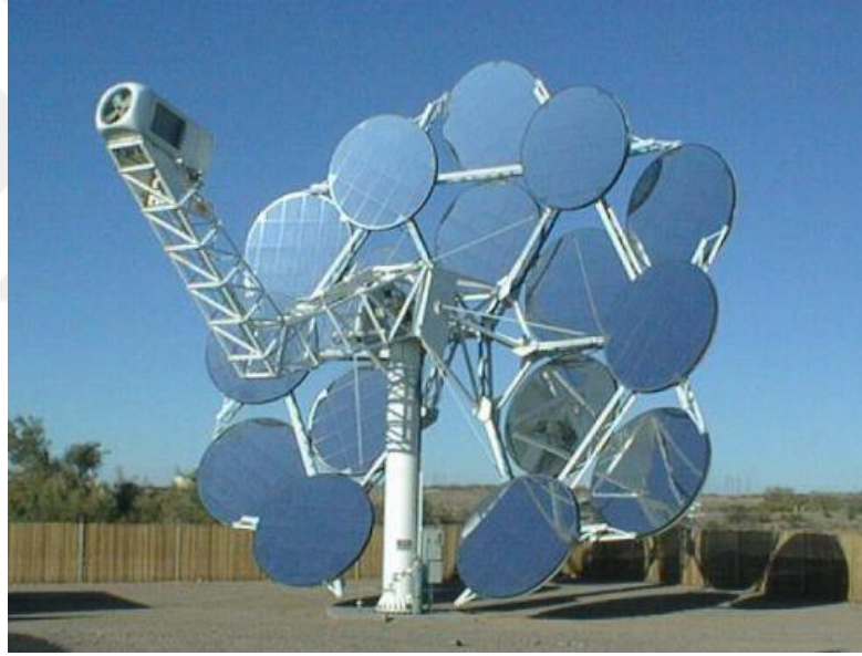
Şekil 2.9. Stirling motorlu parabolik çanak sistemi uygulaması ( URL 18).
