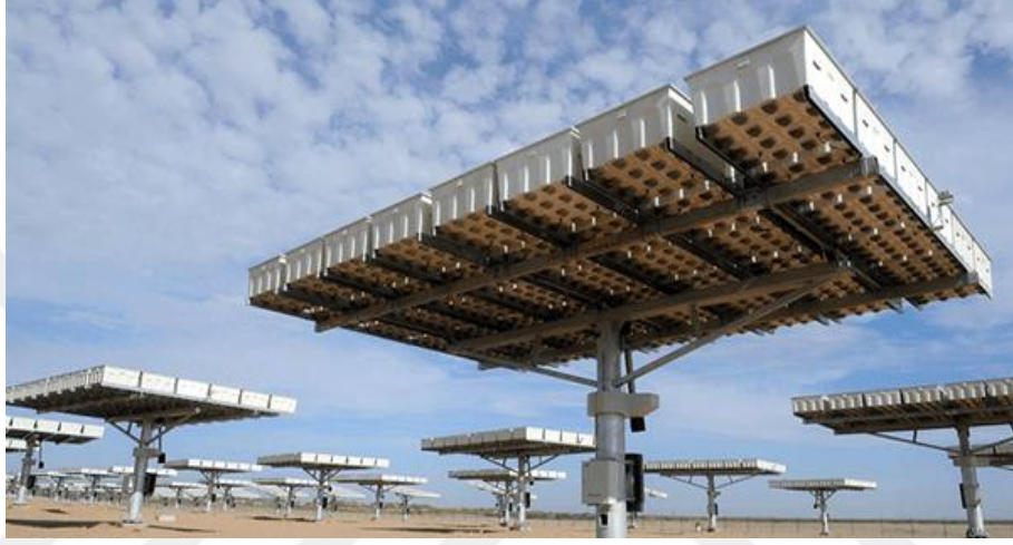
Şekil 2.5. Güneş takip sistemi uygulaması ( URL 18).
