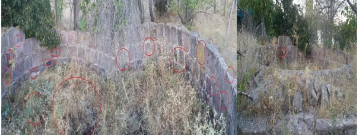
Şekil 4.24. Yeşil Kümbet için gözlemlenen hasarlar
