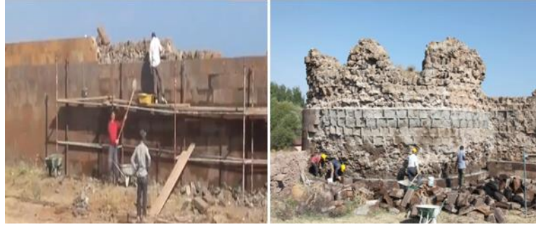
Şekil 3.8. Ahlat Sahil Kalesinde restorasyon çalışmaları
