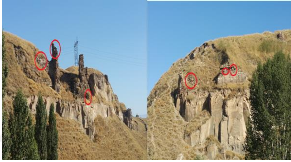
Şekil 4.5. Harabeşehir Kalesinde gözlemlenen hasarlar
