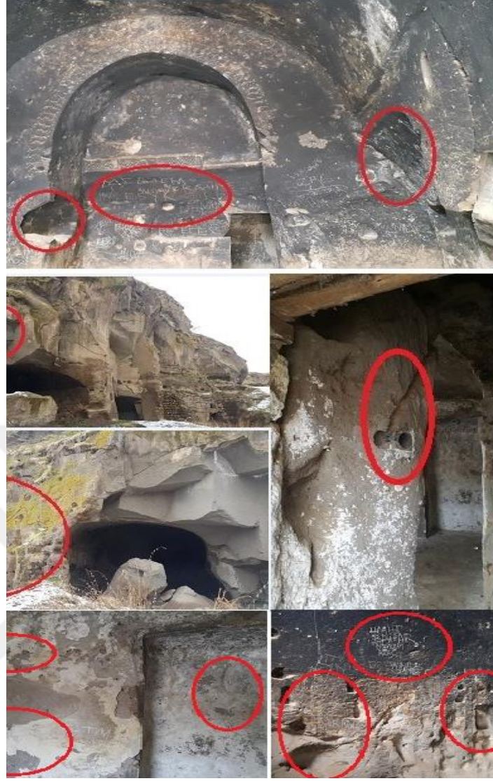
Şekil 4.7. Harabeşehir mağara evlerinde gözlemlenen hasarlar
