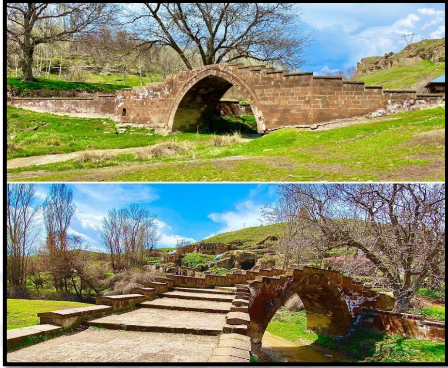
Fotoğraf 4. 25. Ahlat Bayındır Köprüsü
