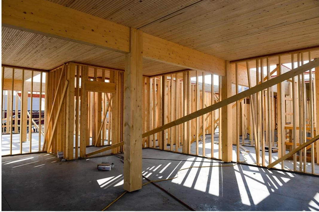
Şekil 4.3 Ahşap yapıdaki dikme, ara dikme ve kiriş örneği (Ulusal Ahşap Birliği, n.d.)
