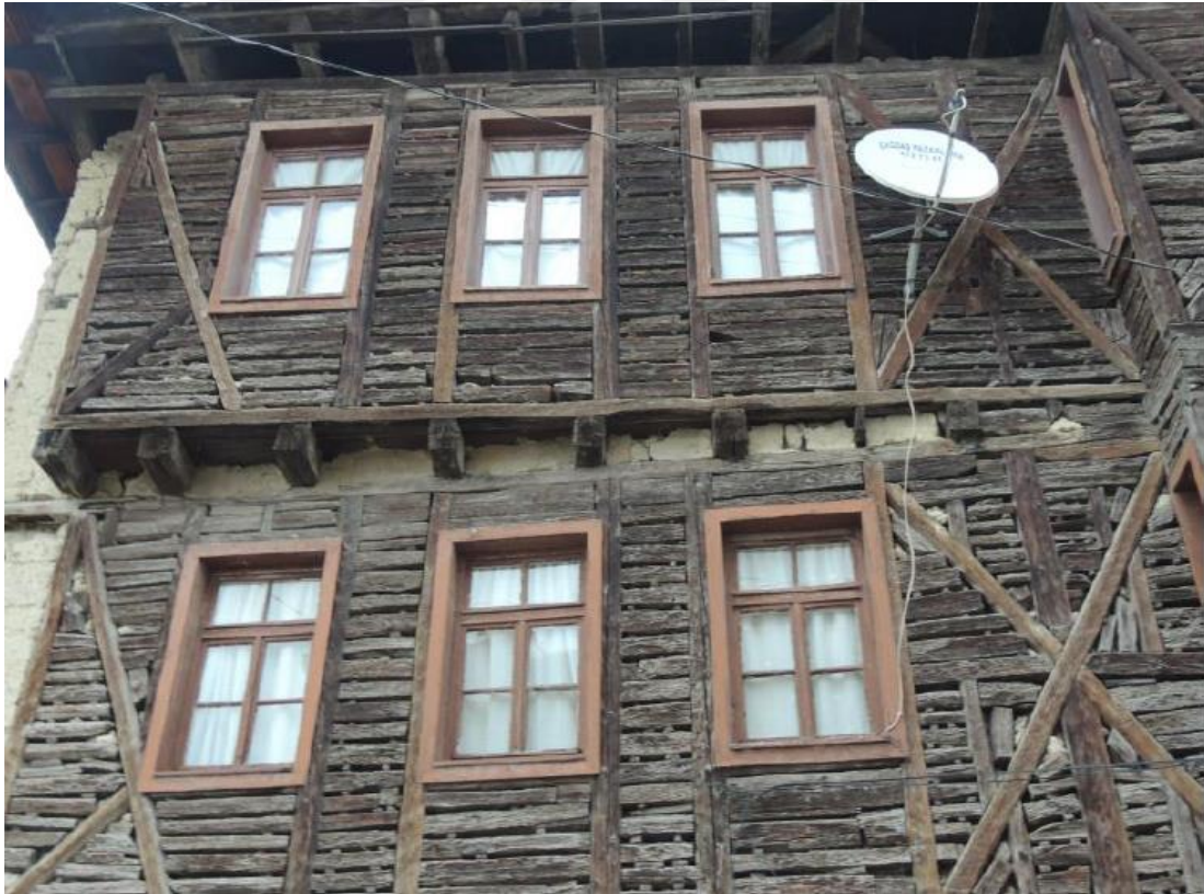
Şekil 4.14 Karabük Safranbolu’da yer alan dizeme tekniğiyle yapılmış duvar örneği (Güneş, 2014)
