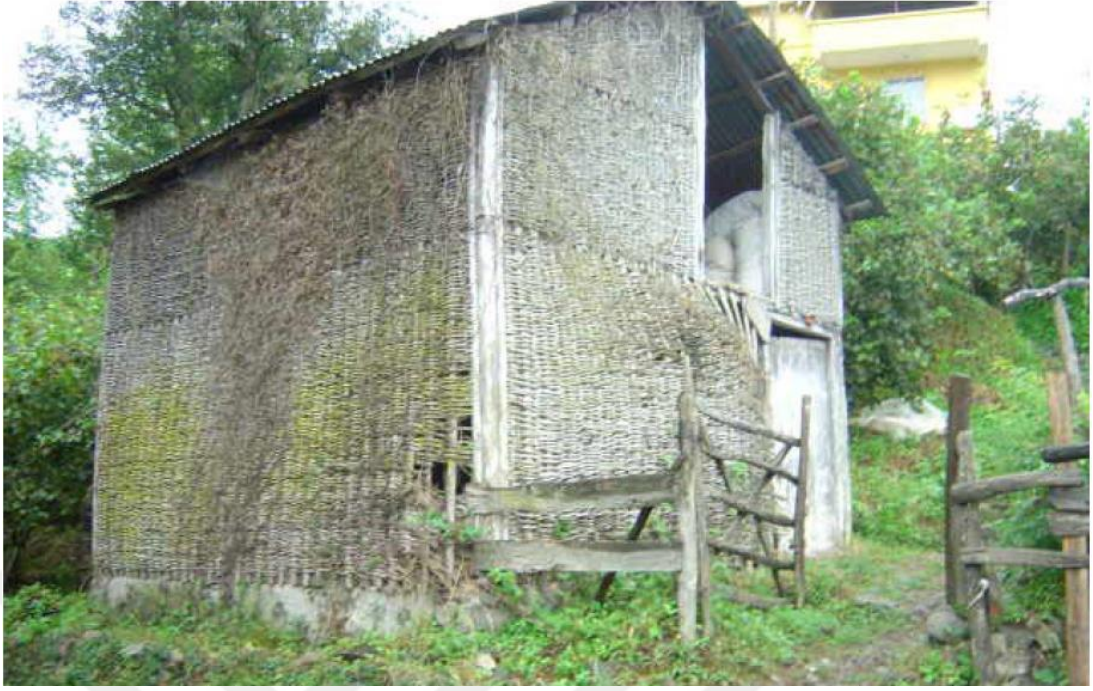
Şekil 4.13 Giresun’da yer alan çöten duvar örneği (Yaman, 2007)
