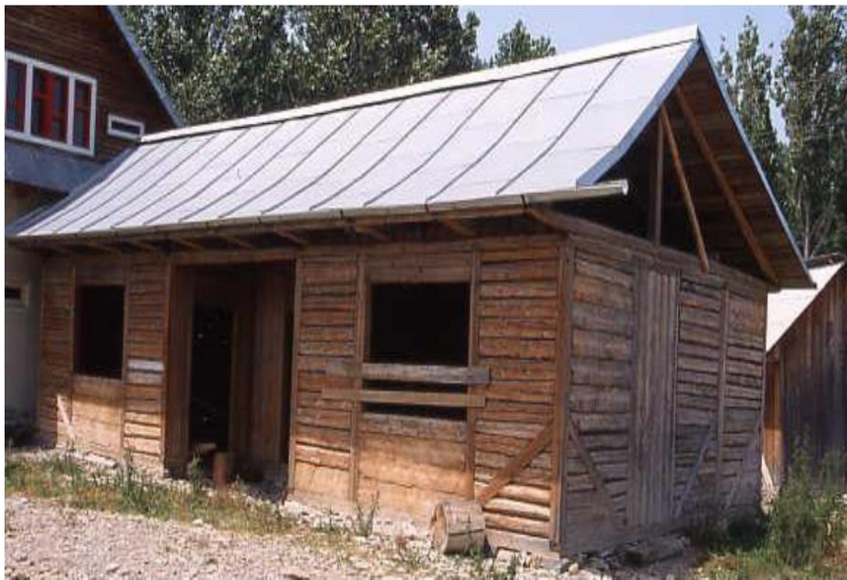
Şekil 4.27 Blok ahşap dolma duvar (taraba) örneği (Saatci, 2020)
