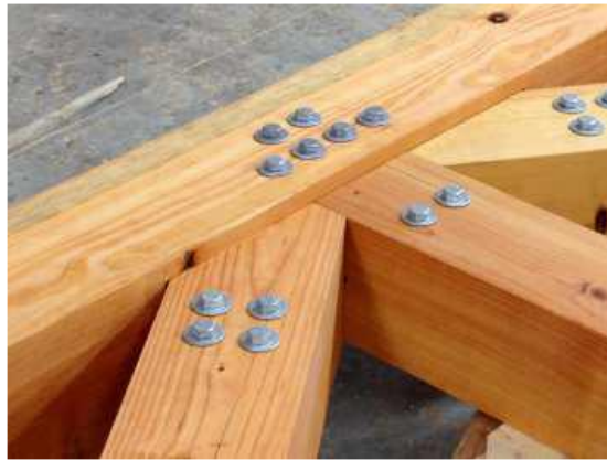
Şekil 5.16 Bulonlu birleşim örneği (Üstündağ, 2014)
