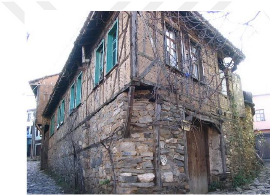
Şekil 4.15 Bursa Cumalıkızık’ta hımış yapı örneği (Işık, 2007)
