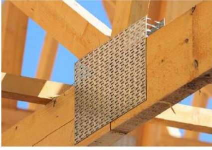
Şekil 5.13 Çivili metal plaka kullanılmış birleşim örneği (Üstündağ, 2014)
