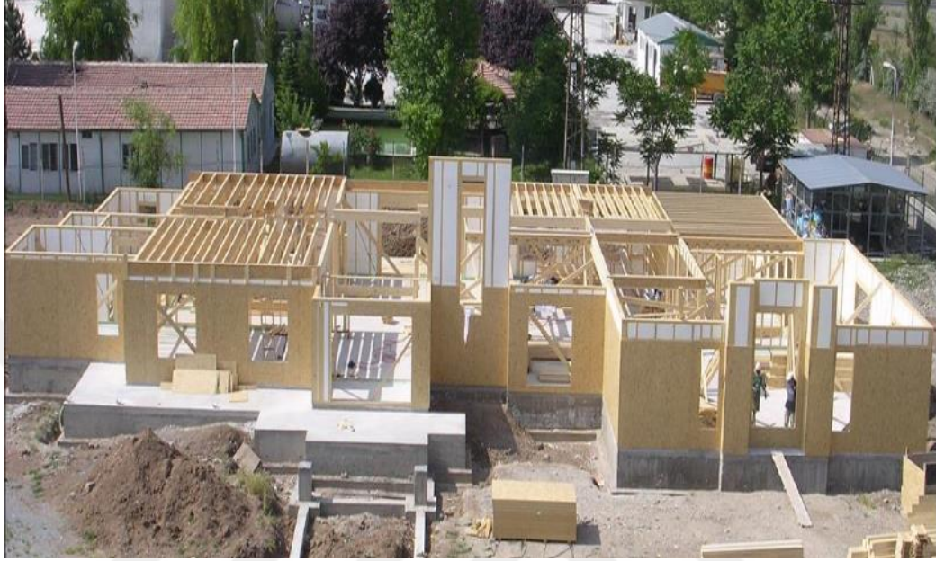
Şekil 4.25 Ahşap panel sistem örneği (Ediz, 2018)
