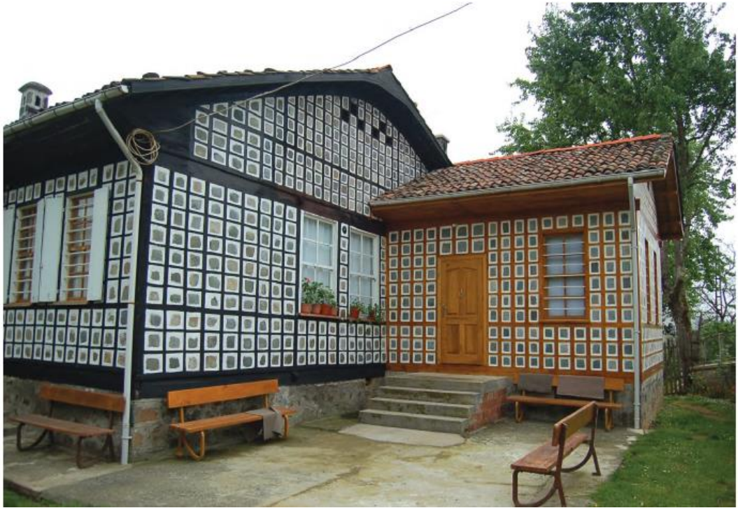
Şekil 4.18 Artvin Arhavi’de göz dolma sistemi (Başkan, 2008)
