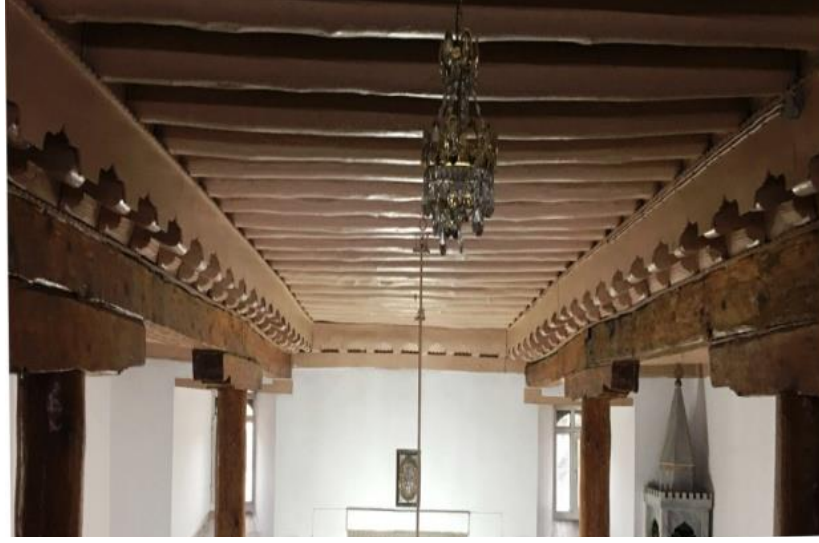
Şekil 3.1 Yanıkoğlu Camisi'nin ahşap taşıyıcı sistemi (Çelik ve Birdal, 2017)
