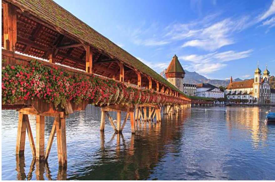
Şekil 1.2. İsviçre Luzern Chapel Köprüsü (URL-2).
