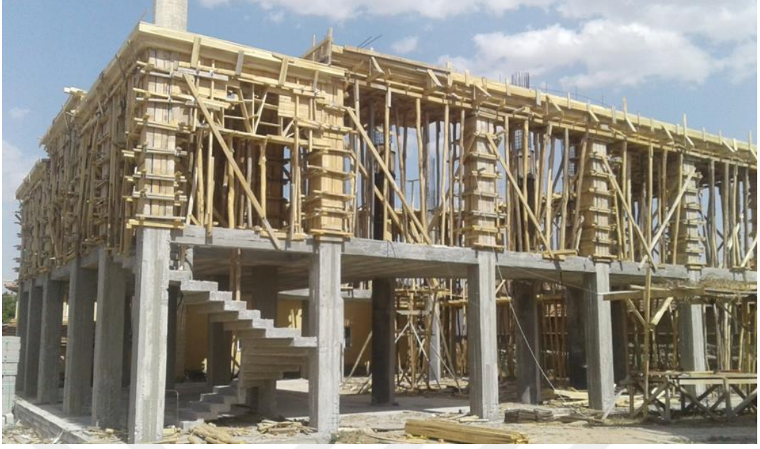
Şekil 1.17: Ahşap Kalıp Sistemi İle İnşa Edilen Yapı (URL-6,2020) .
