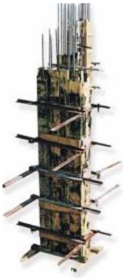
Şekil 1.21: Kolon kelepçesi (MEGEP, 2006).
