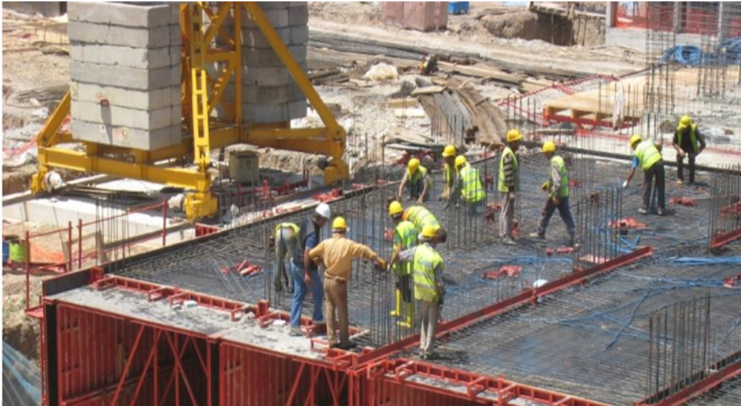
Şekil 1.12: Tünel Kalıp Sistemi (Neru Kalıp, 2008).
