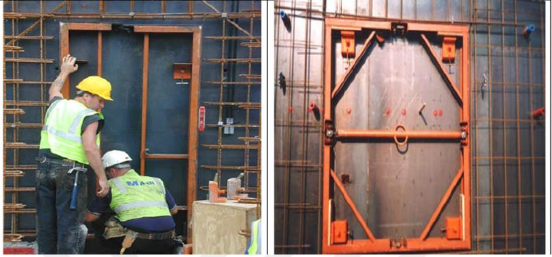
Şekil 1.13: Tünel Kalıp Yapımında Ek Parça Örnekleri (Kıncal, 2006).
