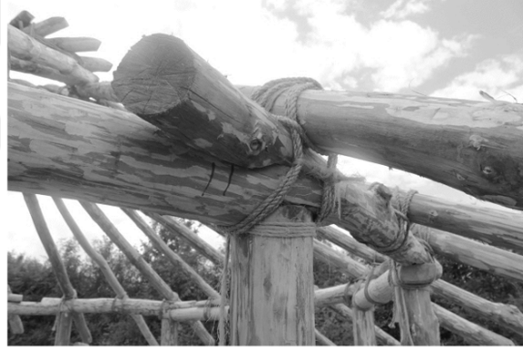
Şekil 9. Ahşap karşılıklı çerçeve kirişlerin ip ile bağlanması (Gustafsson, 2016)
