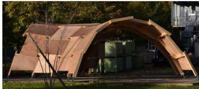
A: Douthe, vd.’nin (2018) ürettiği ahşap karşılıklı çerçeve strüktür pavyon yapısı
