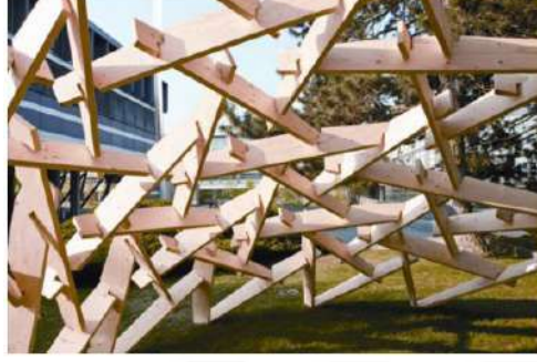
Şekil 15. Çentik bağlantısının örneği; SC Pavyonu (Thönnissen, 2014).
