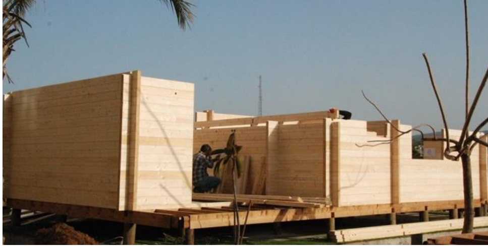
Şekil 2.1. Ahşap duvar elemanı [57]
