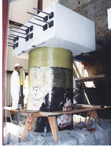
Şekil 3.2. Bir köprünün FRP kompozitler ile sismik güçlendirme
