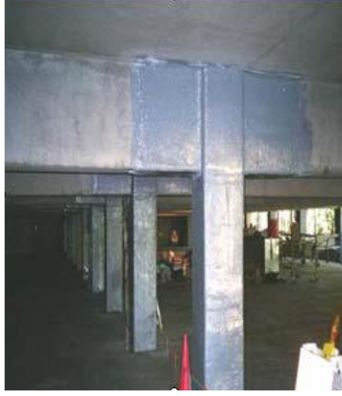
Şekil 3.1. FRP’lerle güçlendirilmiş betonarme kolonlar
