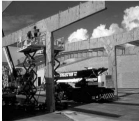
(f) LVL ile oluşturulan geniş açıklıklı kutu portal çerçeveleri (Avustralya Mühendislik Ahşap Ürünleri Birliği'nin (EWPA) izniyle)
