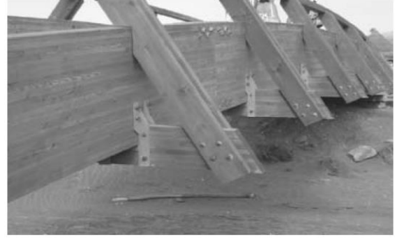
(d) cıvatalı ahşap-ahşap ve cıvatalı çelik askı desteği
