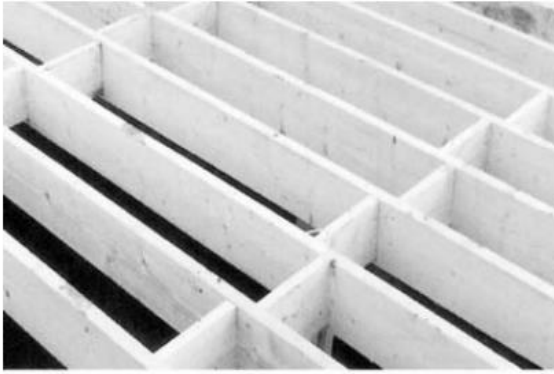
(a) Çapraz sabitlenmiş masif kesitli kirişler
