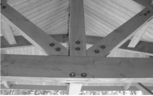
(e) kayma levhali cıvatalı bağlantı
