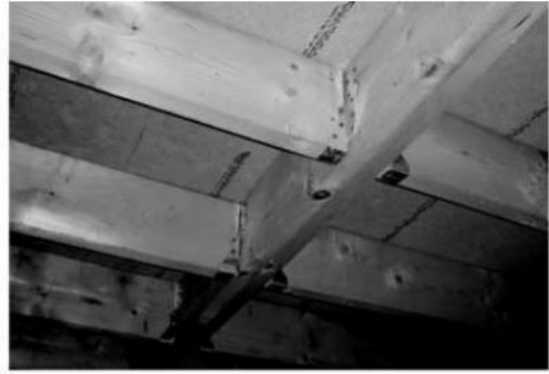
(b) Masif kesit yan kirişler ve döşeme kirişleri
