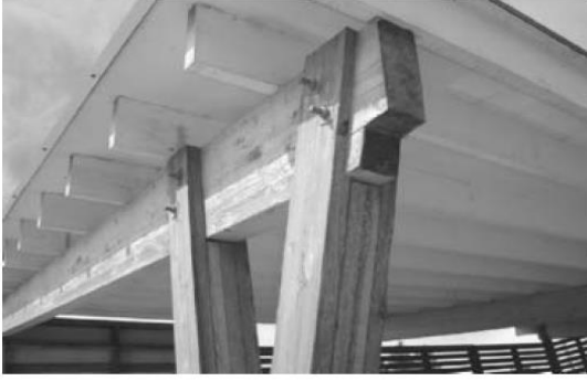
(c) cıvatalı ahşap-ahşap birleşim
