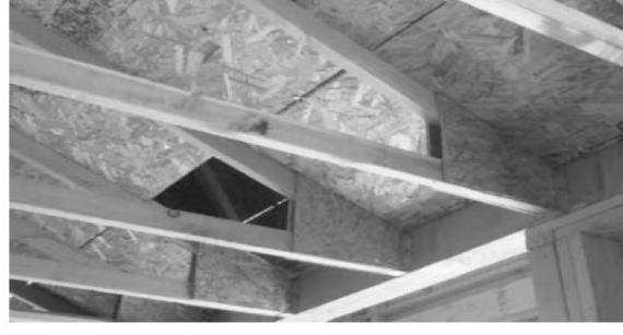
(b) Çivii OSB köşebent eklemleri
