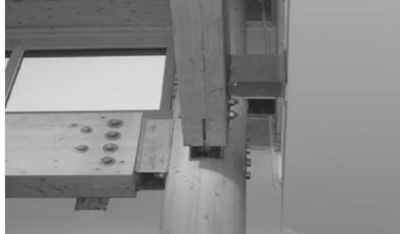
(h) cıvatalı çelik-ahşap birleşim
