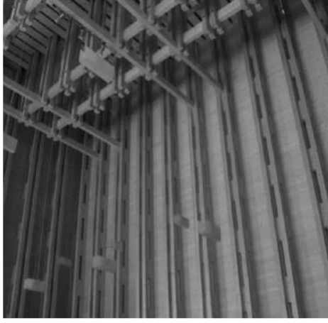
(a) glulam kesitli yapıştırılmış boşluklu kolonlar
