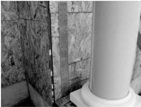
(b) Devrilmeyi önlemek için tutma gergisi
