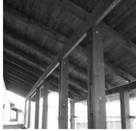
(b) masif kesitli civatalı boşluklu kolonlar
