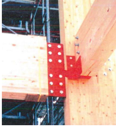
Şekil 2.17 Ahşap kolon-kiriş birleşim detayı (Fairweather, 1992)
