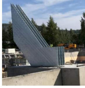
Mjostarnet kolon-çapraz-temel birleşimi (Abrahamsen, 2017)
