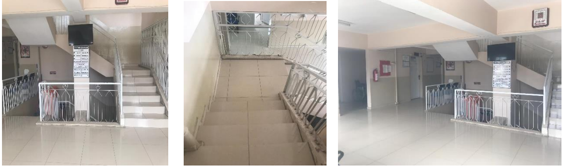
Şekil 4.42. Kültür Aile Sağlık Merkezi merdiven (Baran Arşiv, 2019)
