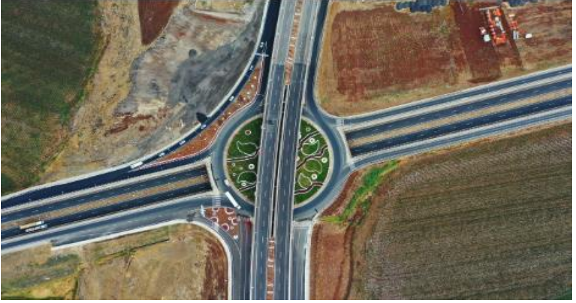
Şekil 3. Bölünmüş yollar 2 ( https://www.kgm.gov.tr )
