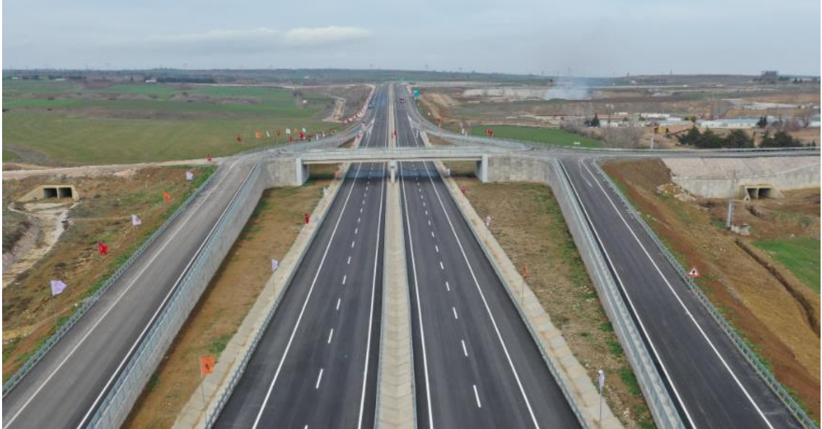
Şekil 2. Bölünmüş yollar 1 ( https://www.kgm.gov.tr )
