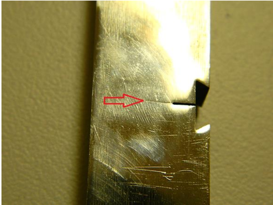
Şekil 5.29b. Yorulma çatlağı ilerlemesi
