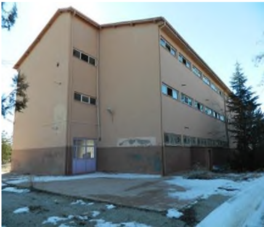
Şekil 12. Pansiyon Kuzey Cephe
