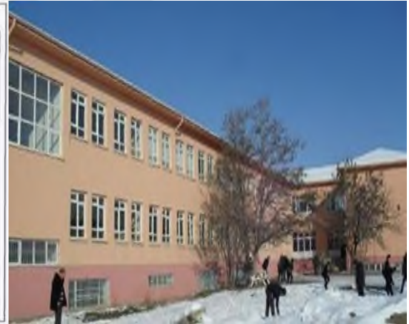
Şekil 5. Derslikler Güney Cephe
