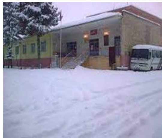
Şekil 9. İdari Bina Güney Cephe
