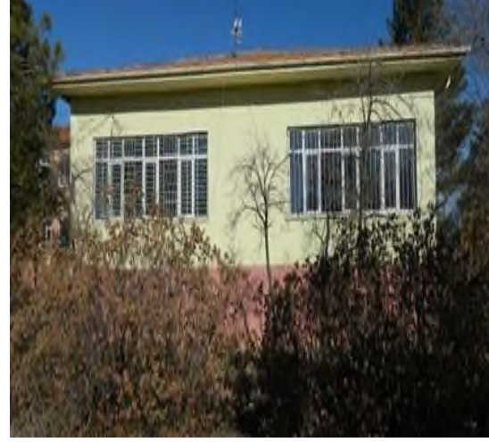
Şekil 11. İdari Bina Güney Cephe
