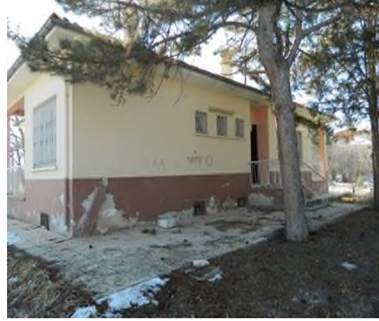
Şekil 29. Lojman Kuzey Cephe
