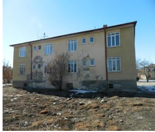
Şekil 27. Lojman Doğu Cephe
