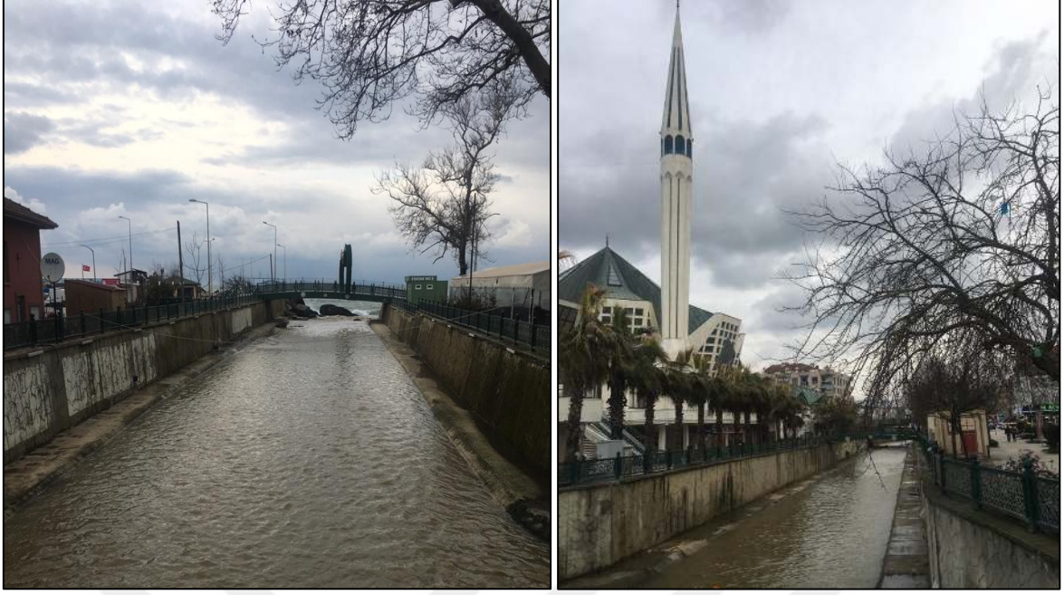
Fotoğraf 4.10. Akçakoca İlçesi Merkez Cami Çevresi
