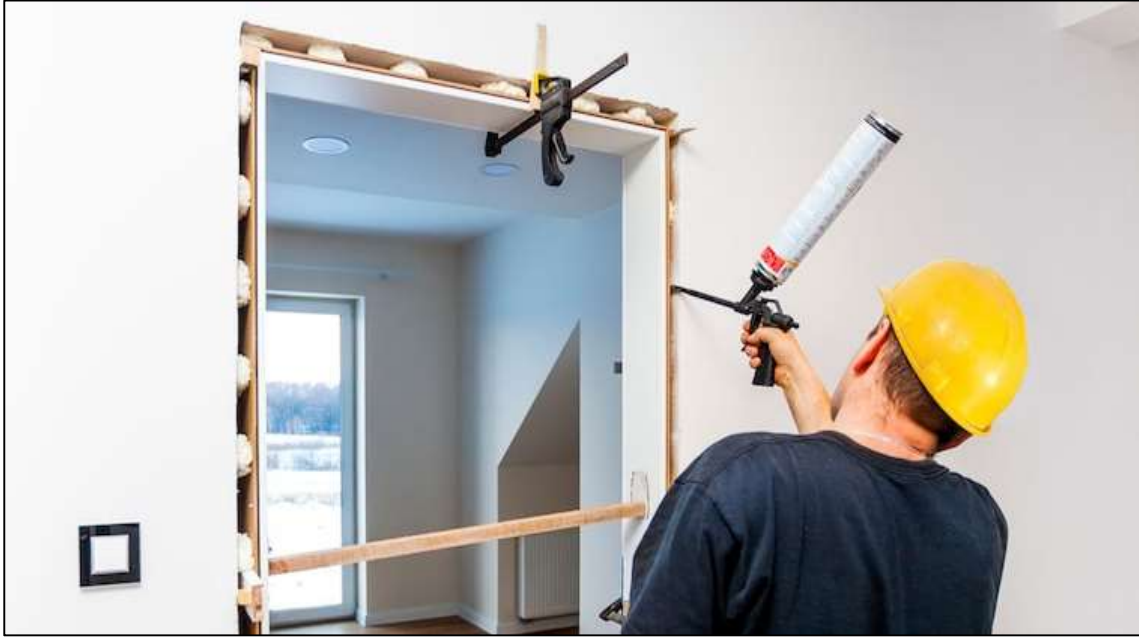
Şekil 2.12. Kapı çerçevesi yalıtım malzemesi ile geçilmesi (Anonymous 2)
