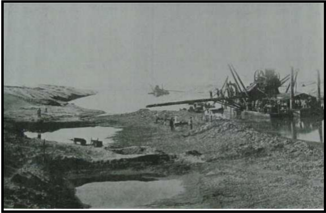
Fotoğraf 14: Buharlı Tarak Makinesi (Steam Dredger) Çalışma Anı
