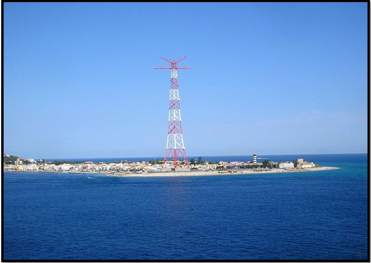
Fotoğraf 8 : Messina Boğazı Üzerinden Elektrik Nakli İçin Sicilya (Torre Faro)'da Bulunan Eski Pilon
