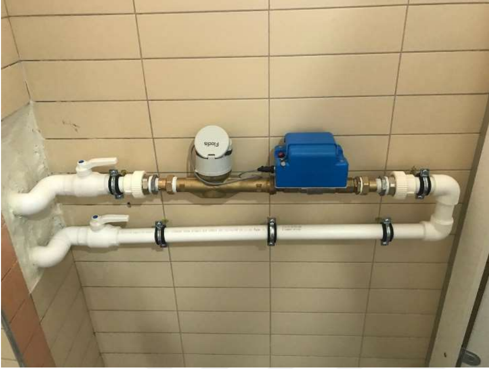
Şekil 3.10. Mühendislik Fakültesi üçüncü kata yeni bir su hattı oluşturularak akıllı su sayacı montajının yapılması
