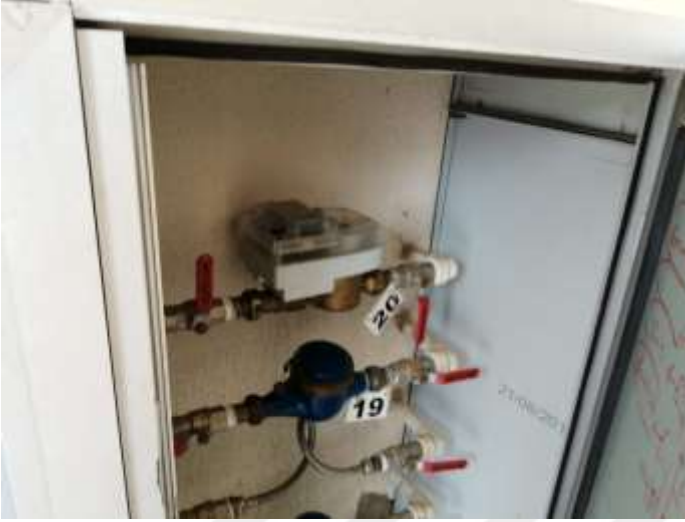
Şekil 4.219. Yakut Çarşısı tuvaletinde bulunan akıllı sayaç vanasının kapatılarak suyun kesilmesine ait görsel
