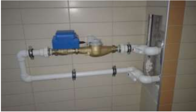
Şekil 3.9. Mühendislik Fakültesi ikinci kata yeni bir su hattı oluşturularak akıllı su sayacı montajının yapılması
