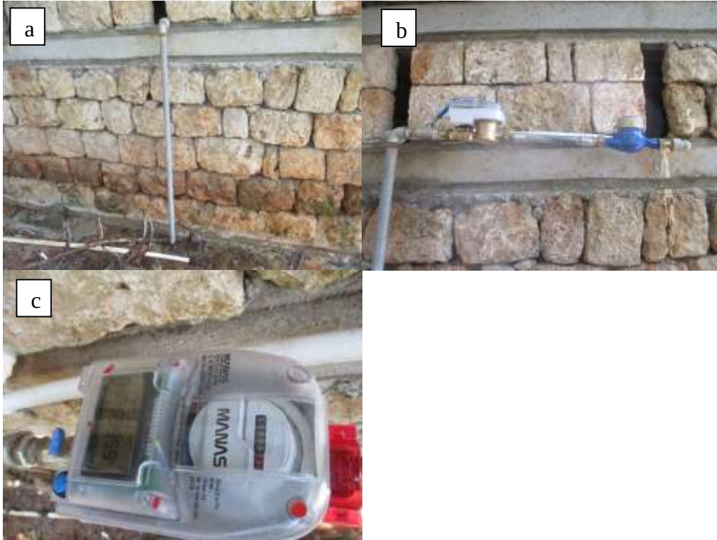
Şekil 3.3. Olbia Çarşısı erkek tuvaletinde 06.03.2019 tarihinde yeni bir su hattı oluşturularak akıllı su sayacının montajının yapılması a) şebeke bağlantısı yapılması; b) akıllı su sayacı montajı; c) akıllı su sayacı okuması
