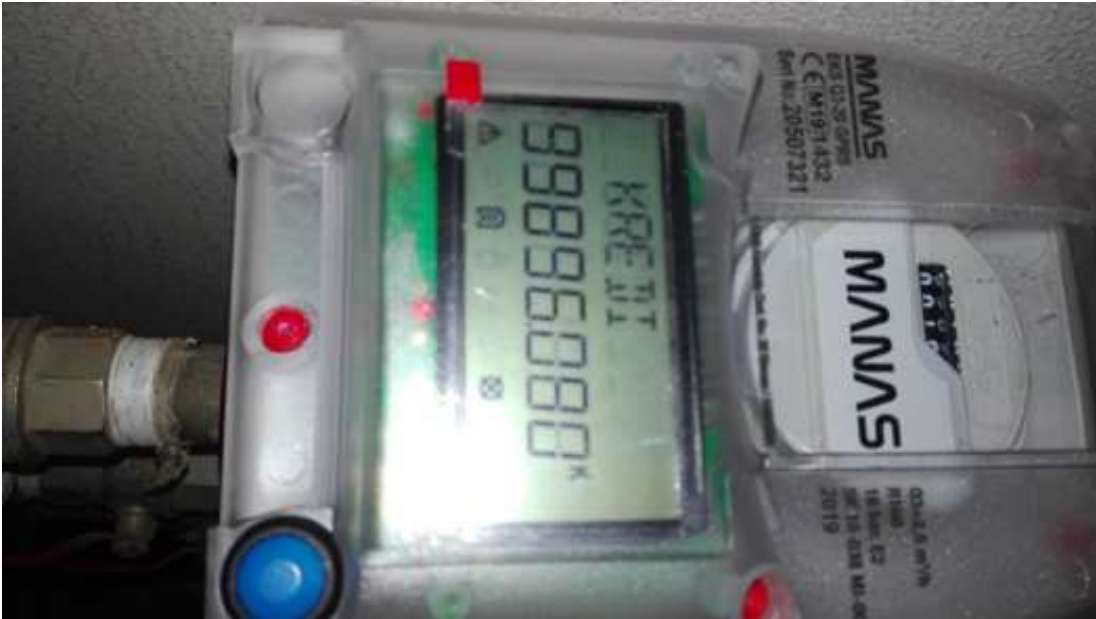
Şekil 3.1. Yakut Çarşısı Tuvaletinde akıllı su sayacının otomatik kapatma vanasının devre dışı bırakılması
