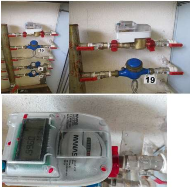
Şekil 3.6. Yakut Çarşısı tuvaletinde akıllı su sayacının montajının yapılması
