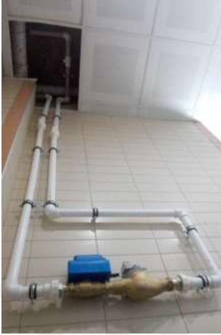
Şekil 3.8. Mühendislik Fakültesi birinci kata yeni bir su hattı oluşturularak akıllı su sayacı montajının yapılması
