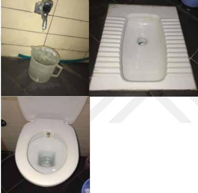
Şekil 4.185. Mühendislik Fakültesi 1. ve 2. kat tuvaletinde su sızıntılarına sebep olan tuvalet ve musluk arızaları (27.01.2020)
