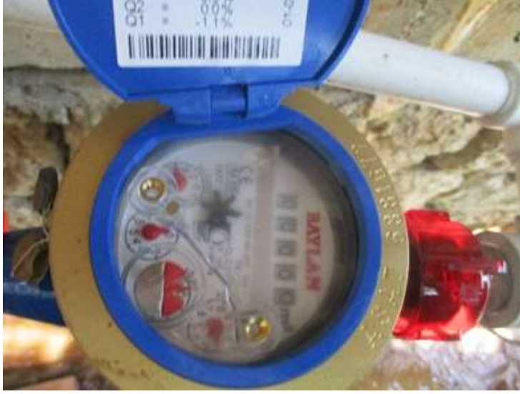
Şekil 3.2. Olbia Çarşısı erkek tuvaleti mekanik su sayacı
