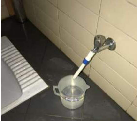
řekil 4.189. Mühendislik Fakóltesi 1. kat tuvaletinde sürekli su sızıntılarına neden olan arızalı musluk
