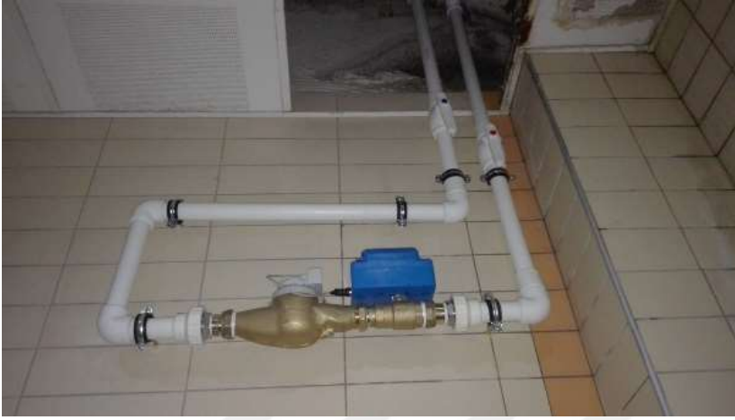
Şekil 3.7. Mühendislik Fakültesi zemin kat tuvaletine yeni bir su hattı oluşturularak takılan akıllı su sayacı montajının yapılması
