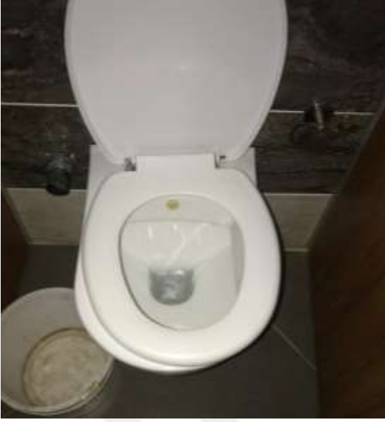
Şekil 4.168. Olbia bayan tuvaletinde 16-18.11. 2019 tarihlerinde sürekli su sızıntısına sebep arızalı tuvalet rezervuarı
