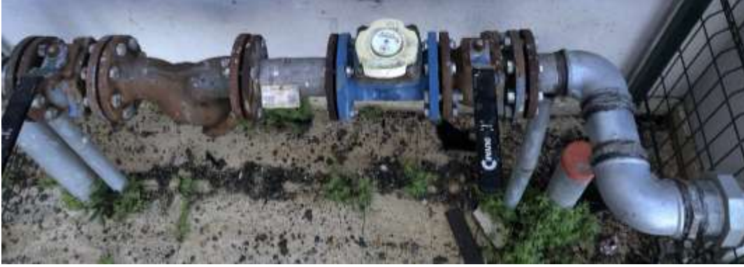
Şekil 4.198. Fakültenin tüm su tüketimini ölçen mekanik sayaç
