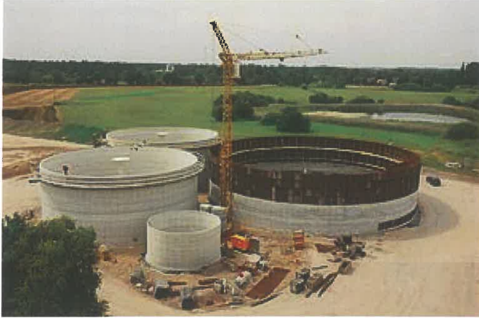
Şekil 4.52. Örnek biyogaz tesisi betonarme inşaatı (Enerji portalı, 2018)
