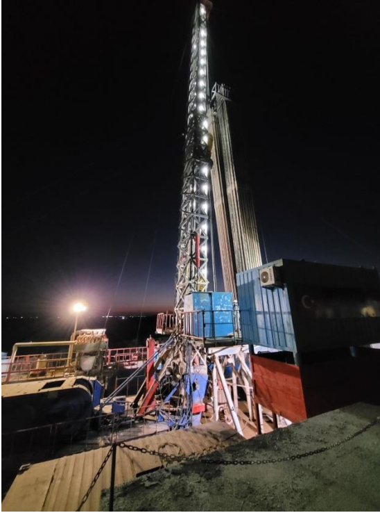
Şekil 4.30. İnceleme alanında yapımı devam eden sıcak su sondaj kuyuları
