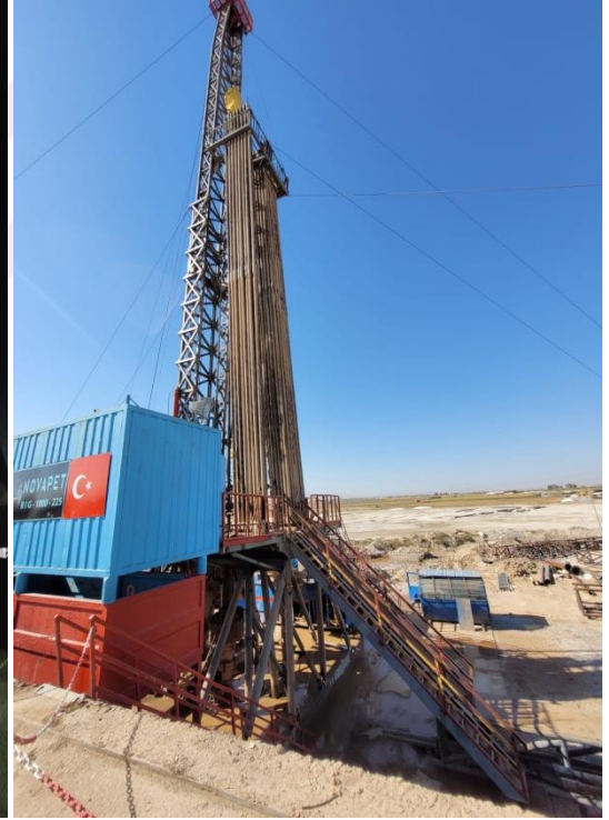
Şekil 4.30. İnceleme alanında yapımı devam eden sıcak su sondaj kuyuları
