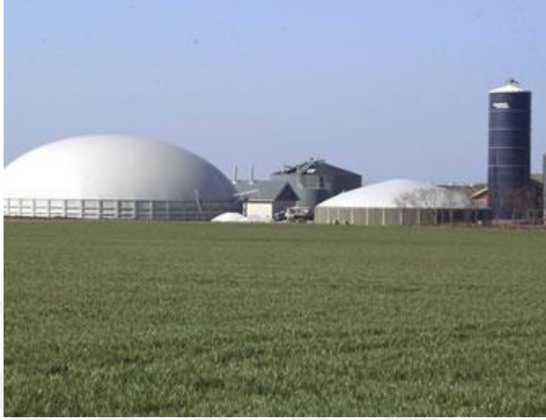
Şekil 3.3: Kömürcüoda biyogaz santrali
