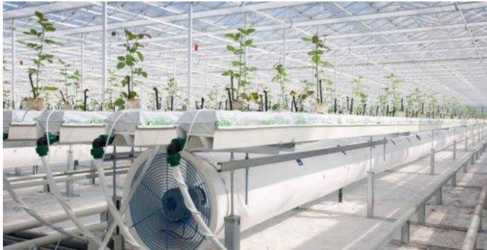
Şekil 3.17. Seralarda havalandırma sistemi örneği
