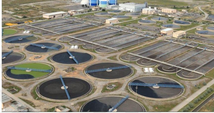
Şekil 1.17: Çiğli atık su arıtma tesisi (URL-51, 2020)
