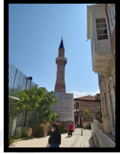
Resim 6.2. Kesik Minare Restorasyonu (Kaynak: Muharrem ORHAN arşivi)
