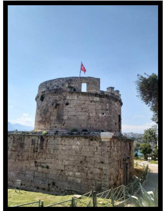
Resim 8.2. Hıdırlık Kulesi Genel Görünüm (Kaynak: Muharrem ORHAN arşivi)
