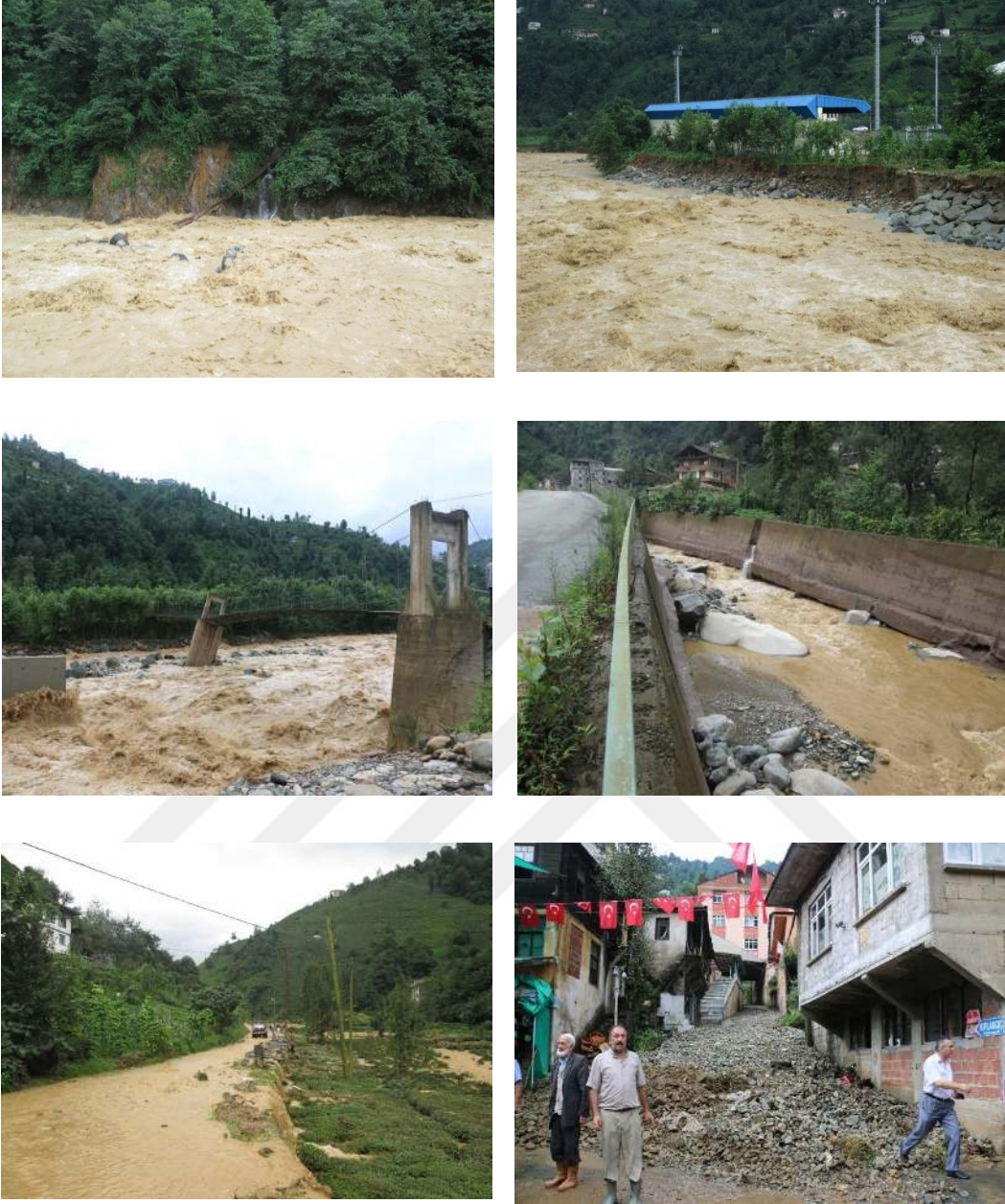
Şekil 12. Taşkın havzasında meydana gelen taşkınlar nedeniyle oluşan zararlar (DSİ,2015).
