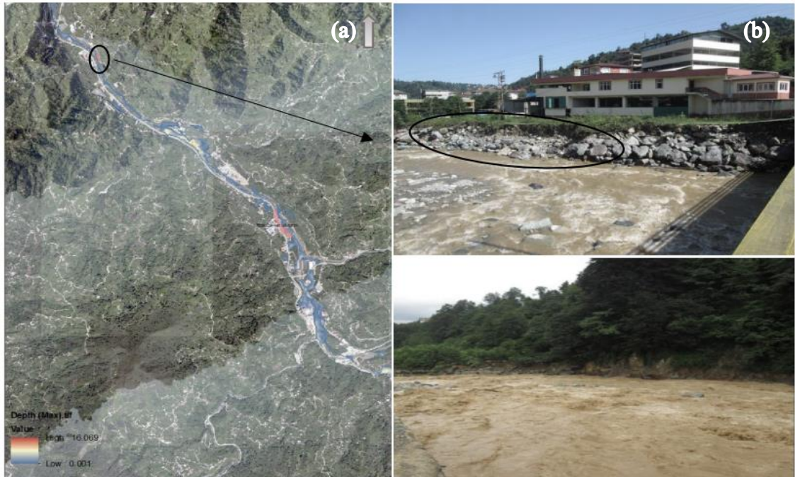
Şekil 20. a. Taşkın modelleme sonucu belirlenen taşkın tehlikesi altında olan alanlar, b: Pekmezli köprüsünün sağ sahilde bulunan taş istinat duvarı yaklaşık 60 metre hasar görmüştür
