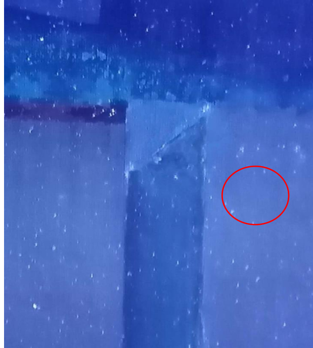
Şekil 4.67: 3 Numaralı Alanın Temizlik Sonrası Morötesi (UV) Işık ile İncelenmesi
