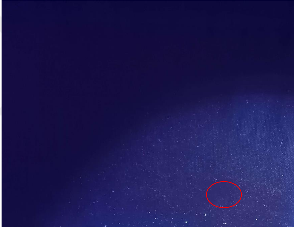
Şekil 4.65: 1 Numaralı Alanın Temizlik Sonrası Morötesi (UV) Işık ile İncelenmesi
