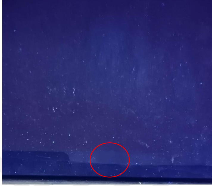
Şekil 4.68: 4 Numaralı Alanın Temizlik Sonrası Morötesi (UV) Işık ile İncelenmesi
