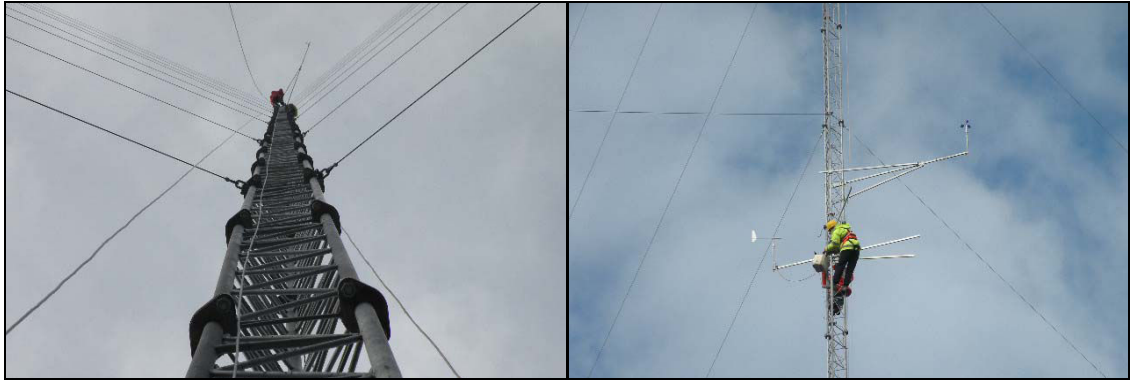
Şekil.3.2. (a) Kafes tip ölçüm direği (b) Kafes tip ölçüm direği kurulumu (Ataseven M., Ataseven S.)
