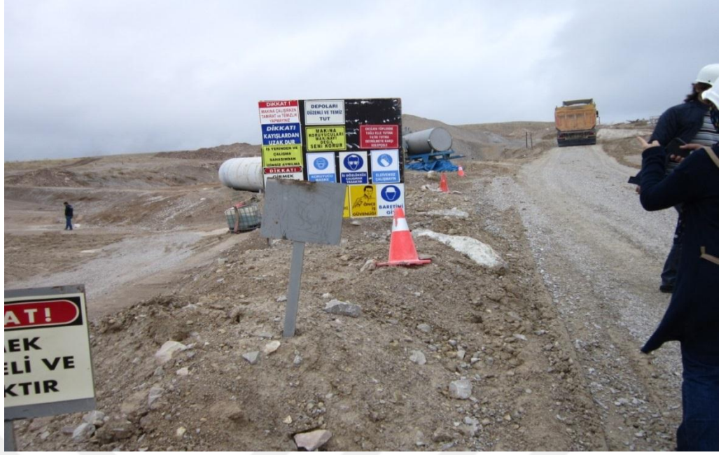
Şekil 3.39: Uyarı levhaları (şantiye girişi).
