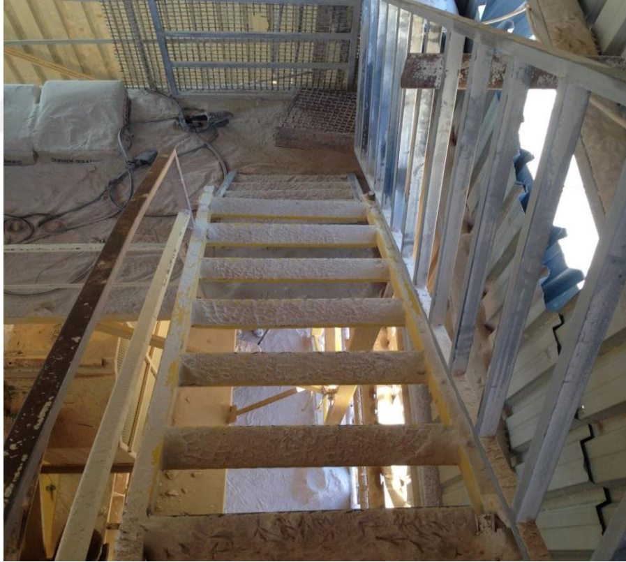
Şekil 3.25: Geçiş yolları ve korumalıklar (doğru uygulama).
