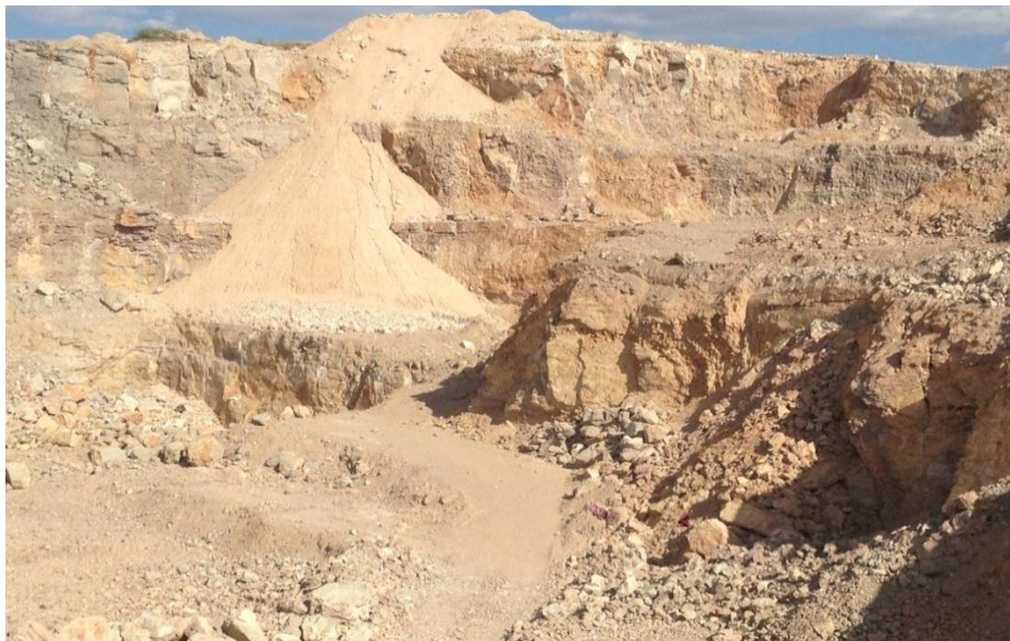
Şekil 3.36: Ocak basamakları genel görünüş (yanlış uygulama).
