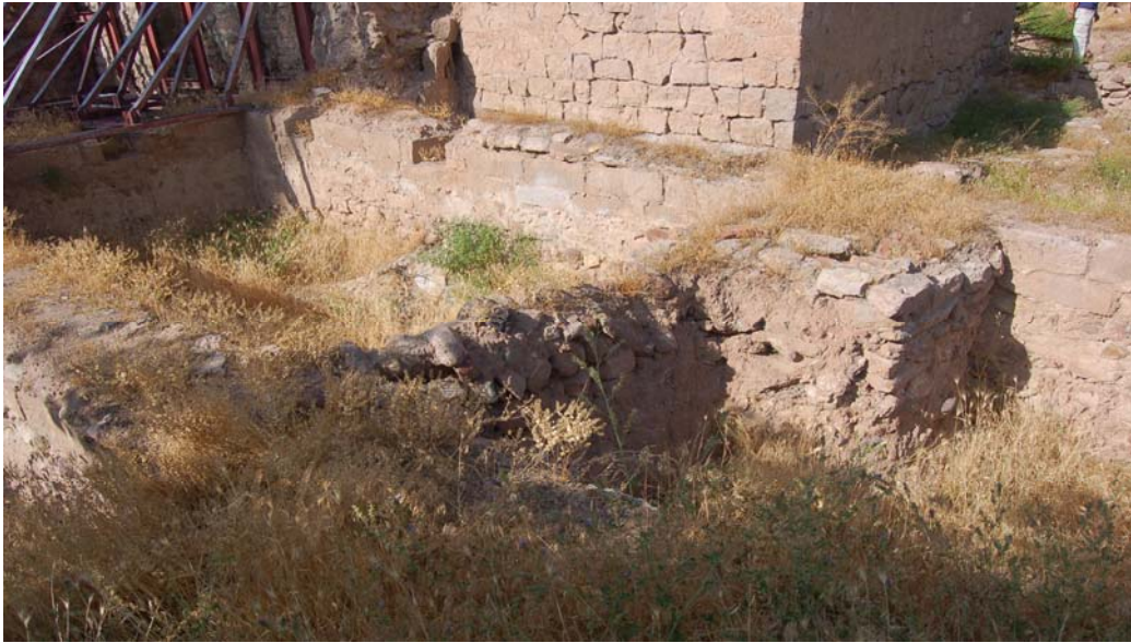
Fotoğraf 10 Melik Mahmut Gazi Hankahının güneybatı cephesinde yer alan oda duvarlarından detay
