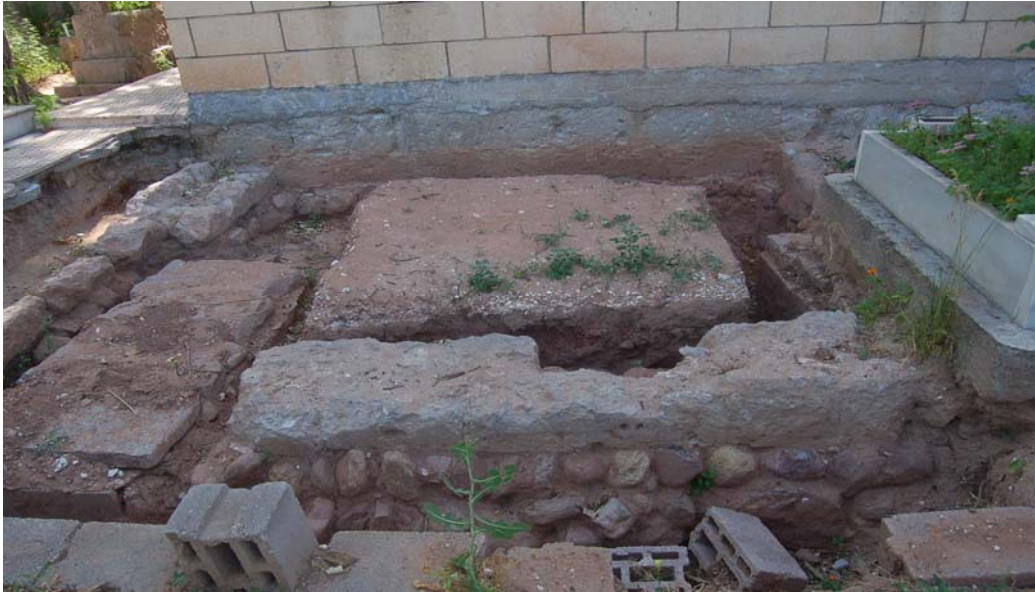
Fotoğraf 78 Mescitin batı cephesi ve Cemalettin Mehmet Aksarayı Zaviyesinin batı cephesinde yer alan tabhane odasının temel kalıntıları
