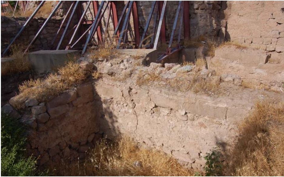
Fotoğraf 13 Melik Mahmut Gazi Hankahının ana mekan duvarlarının demir konstriksiyonla desteklenmesi
