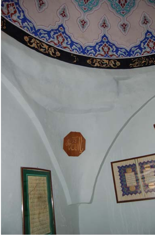
Fotoğraf 207 Türbenin köşe geçişleri
