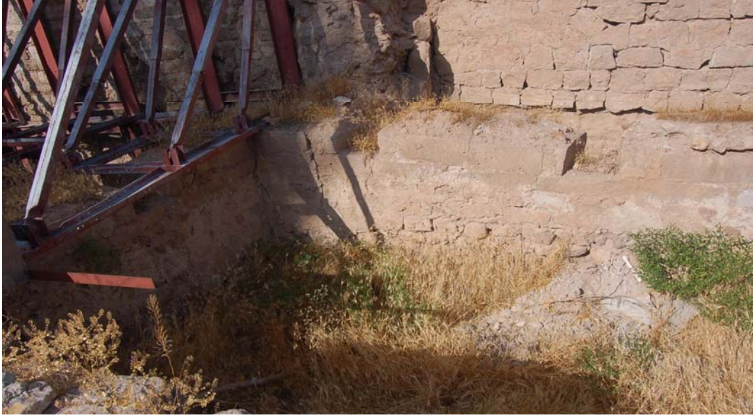
Fotoğraf 15 Melik Mahmut Gazi Hankahının batı cephesinde yer alan oda duvar kalıntılarından detay
