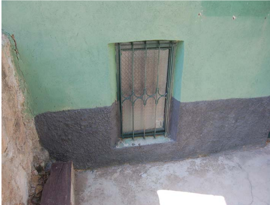
Fotoğraf 102 Şeyh Hamza Tekkesinin giriş kapısının batı cephesinde yer alan pencere düzenlemesi
