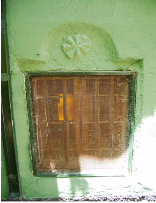
Fotoğraf 120 Mescidin batı cephesinde yer alan pencere alınlığı
