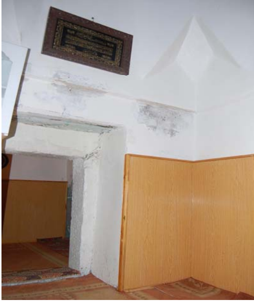
Fotoğraf 151 İtikafhanenin kubbe geçişleri ve yan mekana geçişi sağlayan giriş açıklığı
