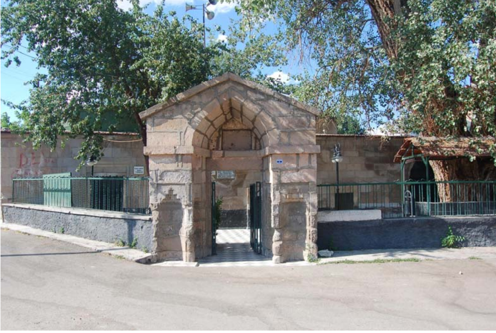
Fotoğraf 164 Şeyh Yusuf Hakiki Zaviyesinin sivri kemerli dışarı taşkın taç kapısı
