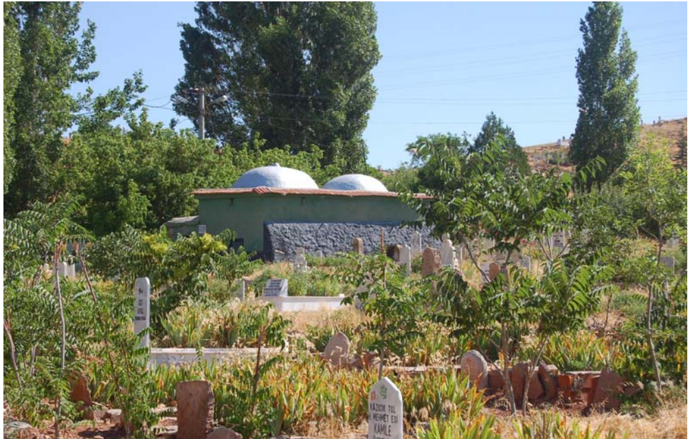
Fotoğraf 90 Şeyh Hamza Türbesinden genel görünüm
