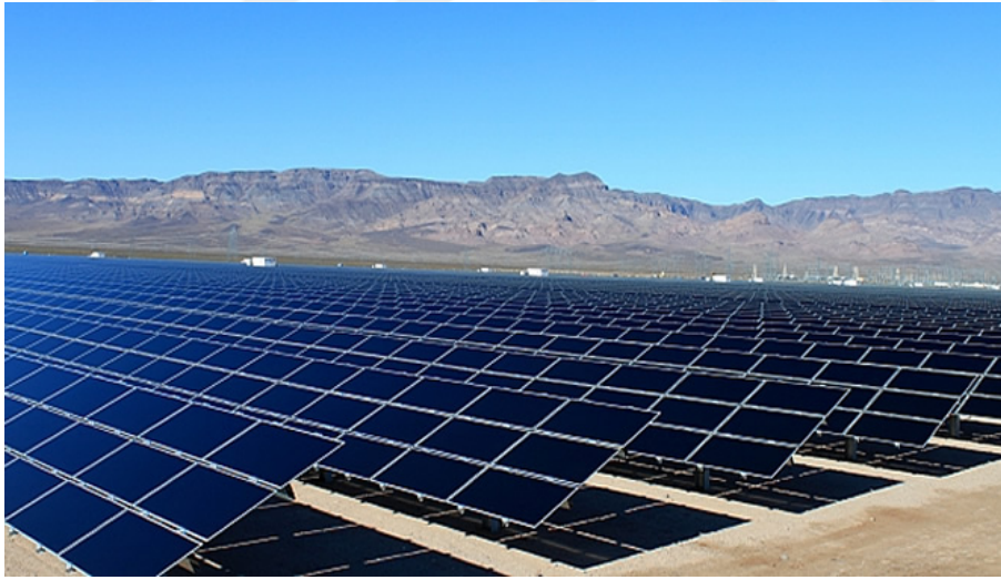
Resim 1.1. Güneş enerji panelleri
