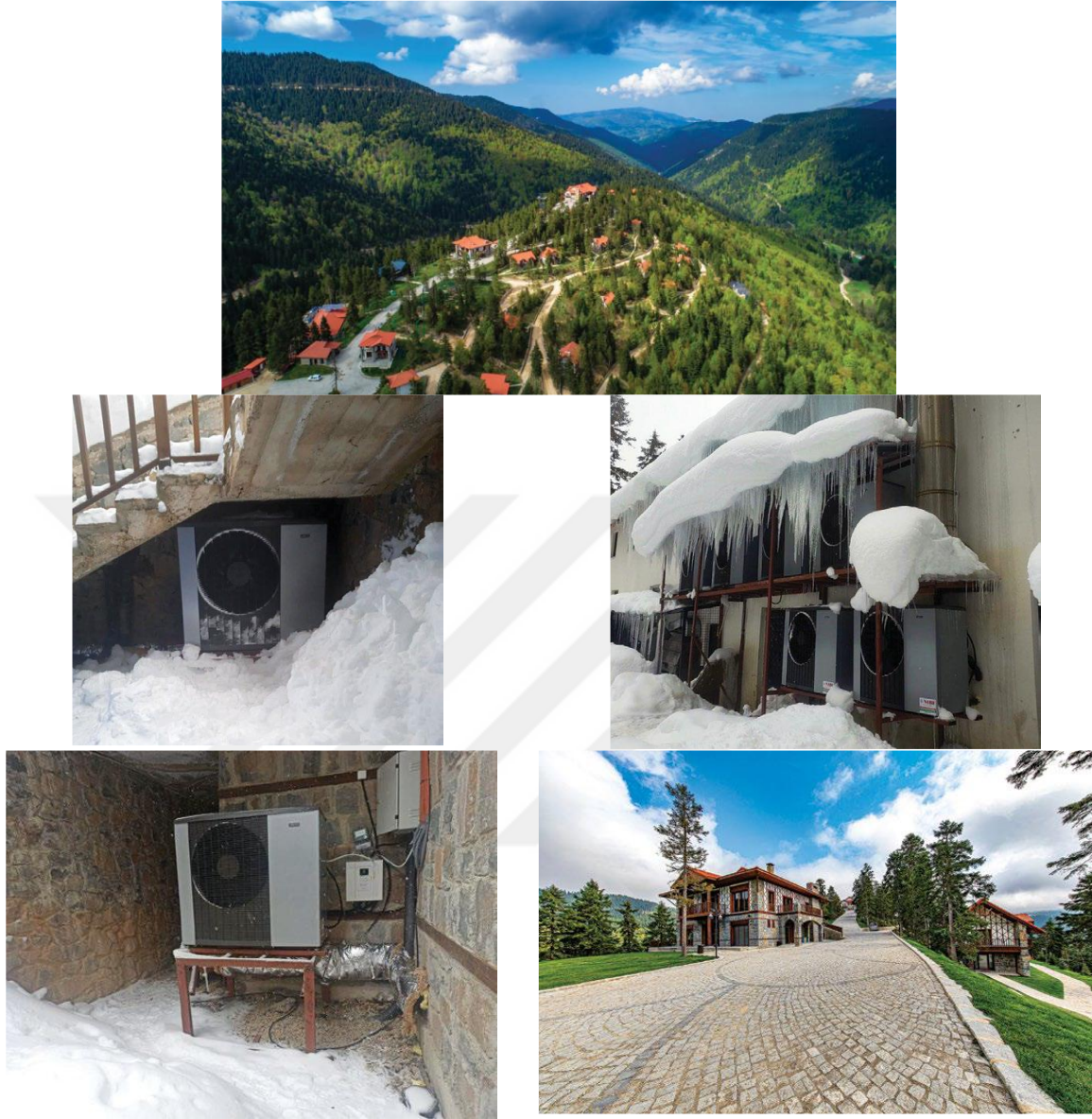
Şekil 20: Foleya Mountain Resort Otelinde Uygulanan Havadan Suya Isı Pompası Sistemi
