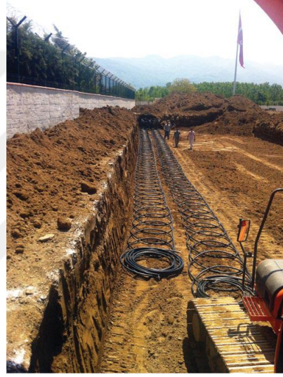
Şekil 23: Düzce Çiftlik Projesinde Uygulanan Toprak Kaynaklı Altı Borulu Sudan Suyu Isı Pompası
