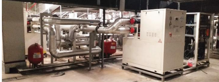
Şekil 22: Ankara Yüksek Hızlı Tren Garı’nda Uygulanan Su Kaynaklı Isı Pompası ve Free-Cooling Sistemi
