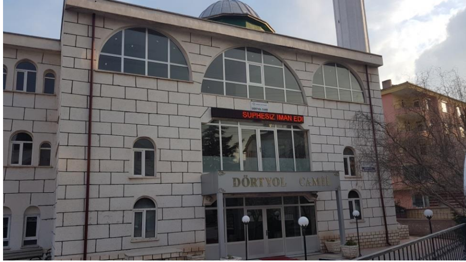
Şekil 28 Dört yol camii.
