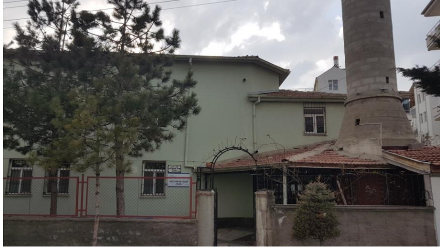
Şekil 25 Hacırahime Aydın camii.
