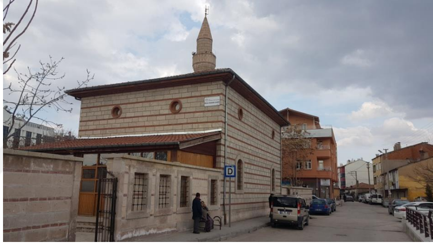
Şekil 23 Rıza hasan camii.
