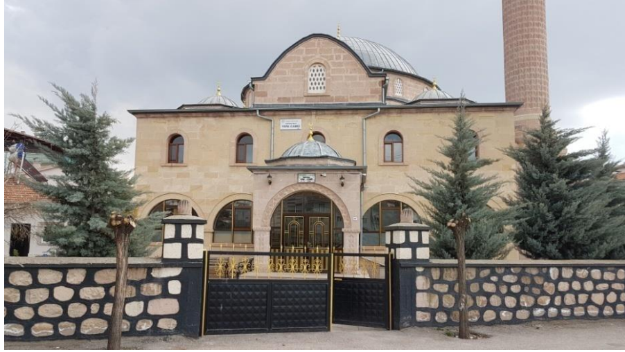
Şekil 34 Yeni camii (nakkaş mahallesi).
