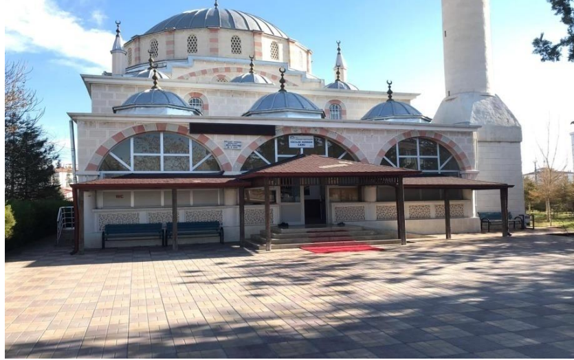
Şekil 43 Hacılar harmanı camii.
